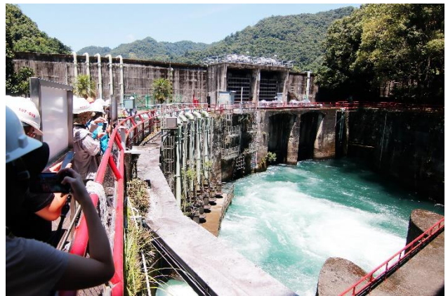
電廠尾水池(白冷圳新取水口)
