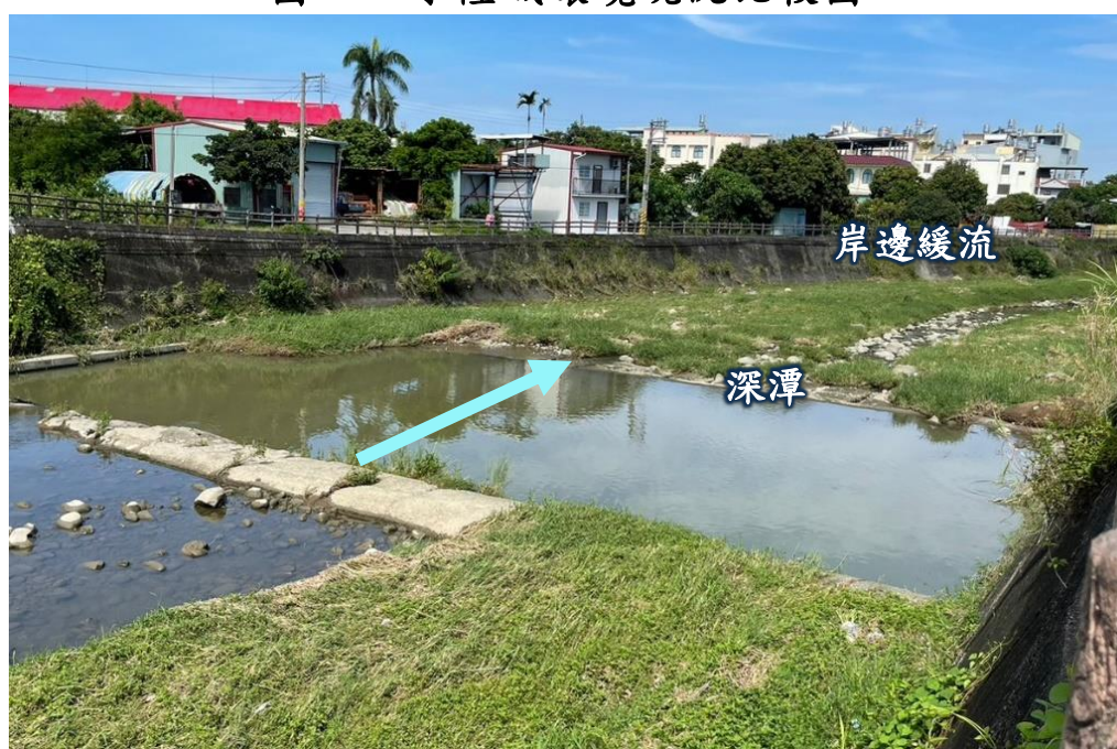
圖4-5 博愛橋下游跌水構造物照片
