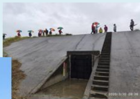
後龍堤防及附屬水門
