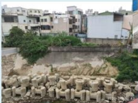
客雅溪排水印順橋護岸保護工
