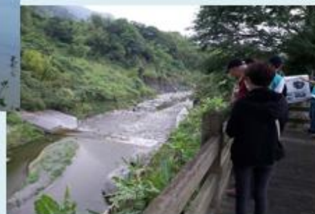
鰲溪豐南橋堤防保護工
