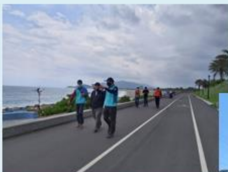
南濱海堤附屬水防道路
