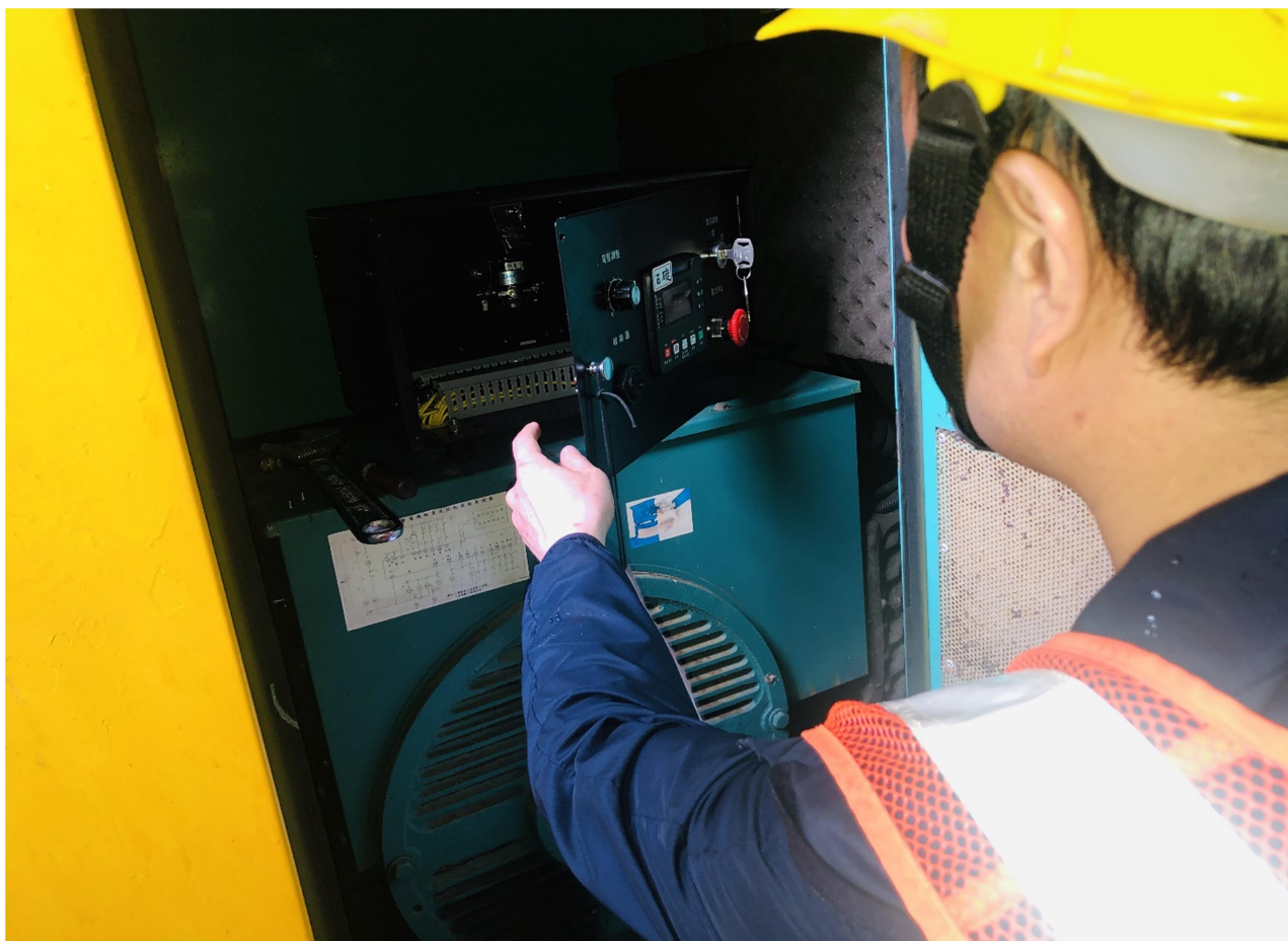
石碇場發電機試運轉
