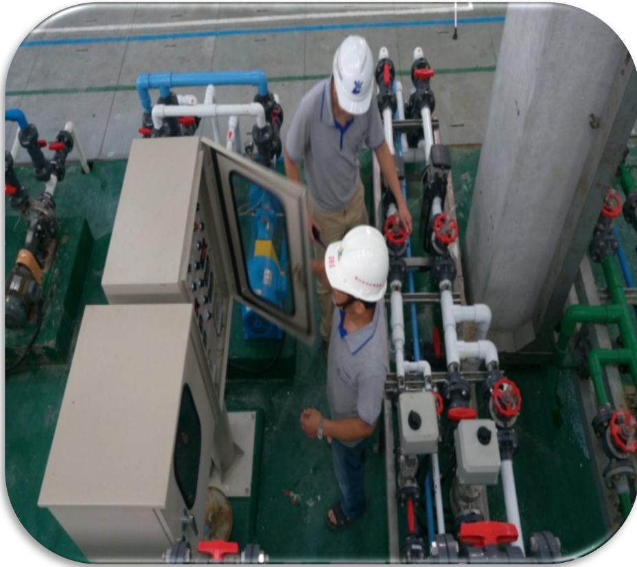
108.5.8 高濁度原水因應演練-機電組排除加藥機故障
