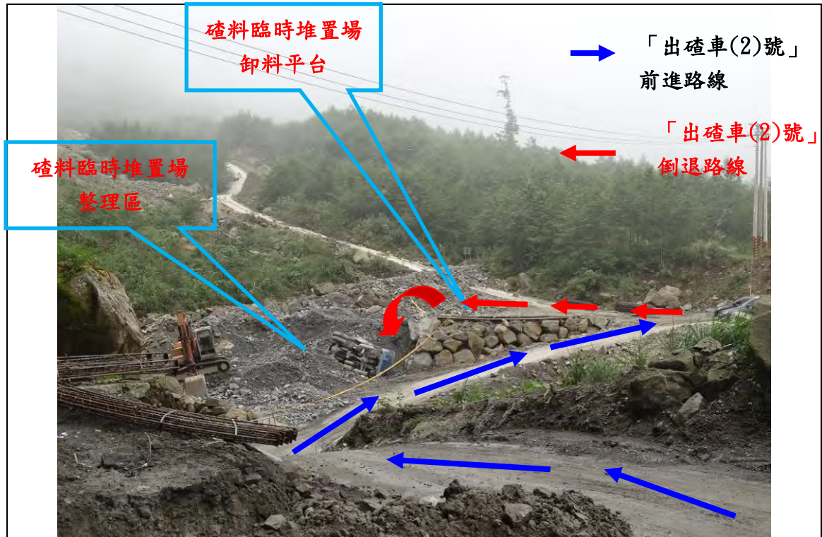
照片 1：災害現場之礫料臨時堆置場，以堆置之礫料整理出一卸料平台，呈南北向，作為出礫車卸料之道路，該卸料平台寬度約 9.5 至 10.0 公尺，長度約 15.3 公尺，平台北側處高度約 3.0 至 4.0 公尺不等。平台北側下方有一礫料整理區，寬度約 9.5 至 10.0 公尺、長度約 20.0 公尺
