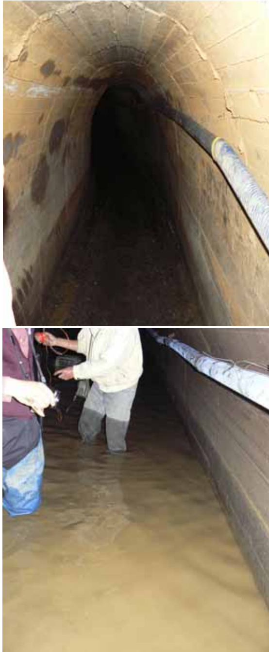
照片 1,2：隧道(引水道)內約 0K+135 公尺之地面有積水，水深度 42 公分
