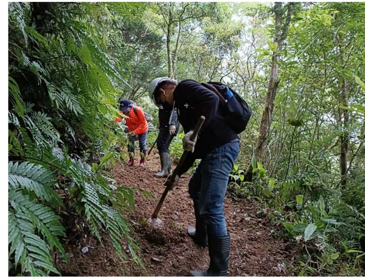
挖掘邊坡拓寬 工項現地施工
