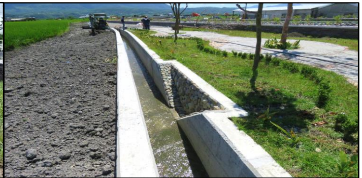
側溝緩斜生態坡道
