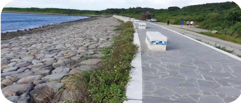
拋石護坡：禦潮消能營造多孔隙環境
