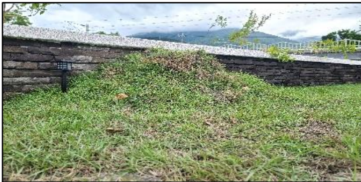
景觀矮牆生態土坡
