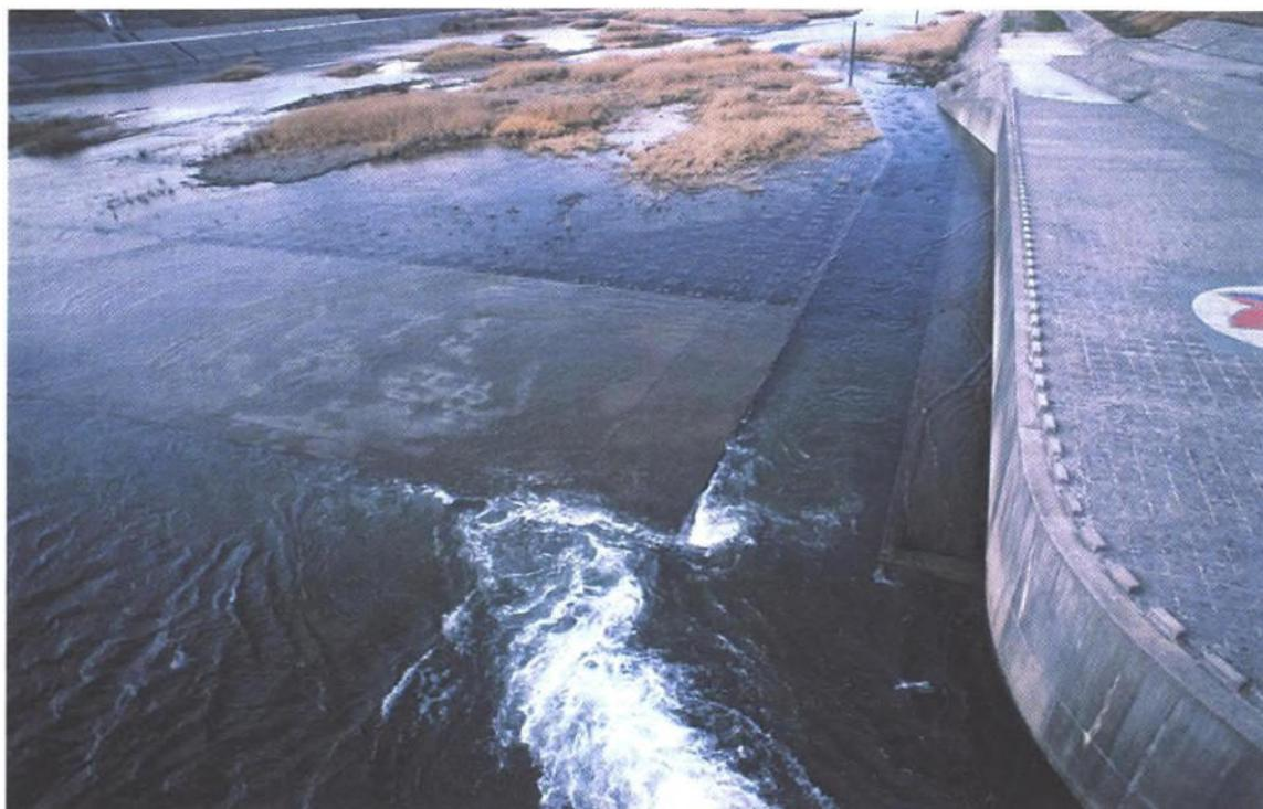
於魚道入口下游端周邊的保護河床工程表面設置凹部，形成明顯之引導水流，以利順利流入魚道下游端(上圖正前方右側)。此外透導水從遠處引入發揮誘導及防止誤入攔河堰正下方的機能。(山國川水系的山國川平成大堰)
