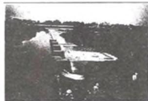
全面溢流的扇型階梯式魚道，越往上游流速越大
