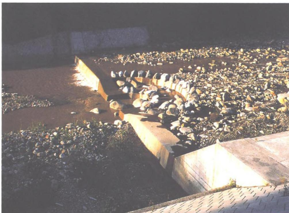
攔砂落差工程雖然採用本體斜面式魚道使落差階梯化固然很好，但僅鋪設石頭，和溢流處尚有 40 公分之落差，魚類無法上溯。
