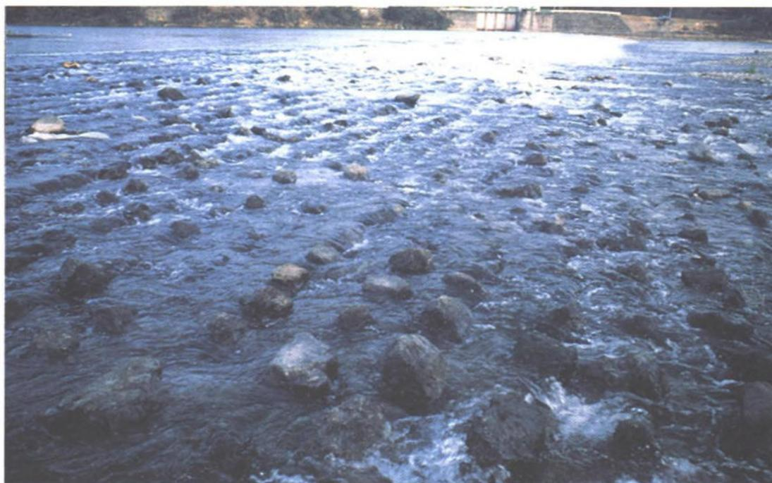
水道型全斷面式魚道的案例
