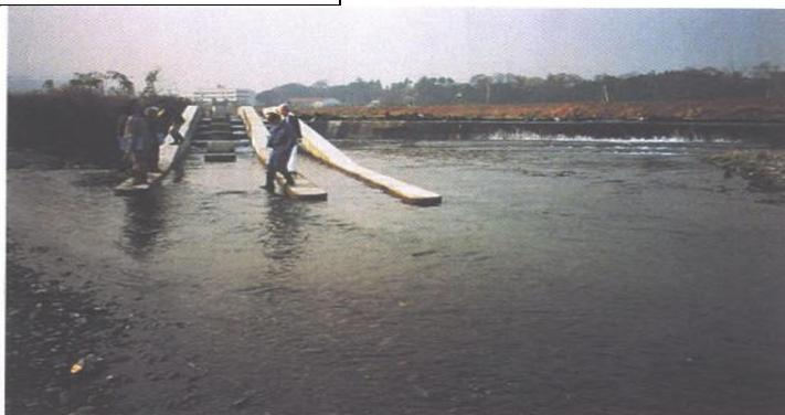
突出於下游端的魚道使游入攔堰正下方的魚類無法溯游
