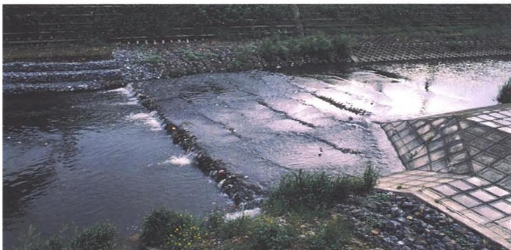
(完工當時)大半流水流到平鋪的石籠處時變成伏流。
