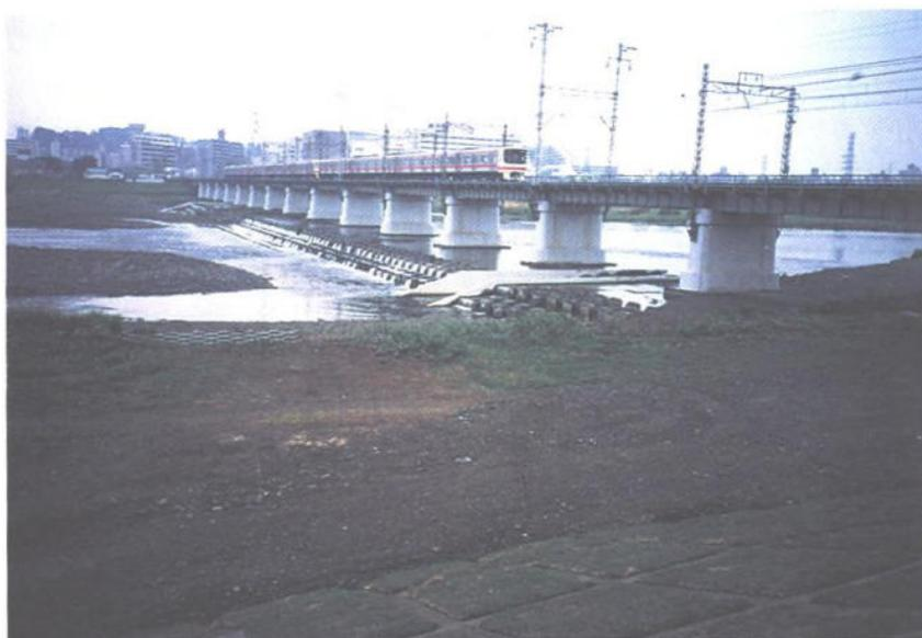
多摩川水系多摩川 京王電鐵路本線河床保護工程 全景
