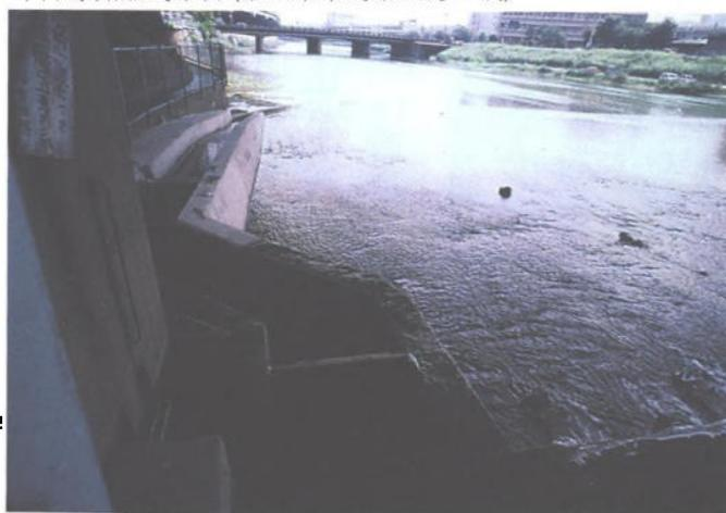
為了緩和攔河堰正下方水躍部分的落下衝擊，以斜坡道銜接最後段落差下方的淵池，並設置提供稚齡香魚下降用的專用魚道。
