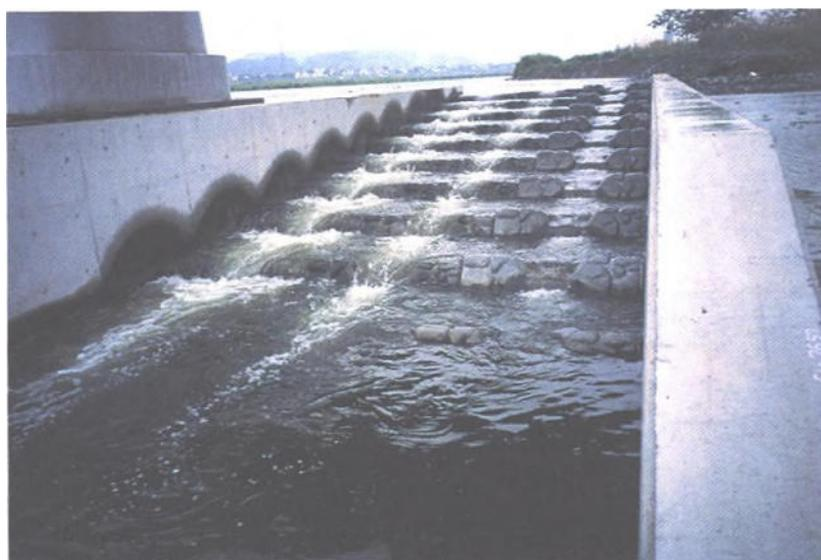
多摩川水系多摩川 京王電鐵路本線河床保護工程之魚道
