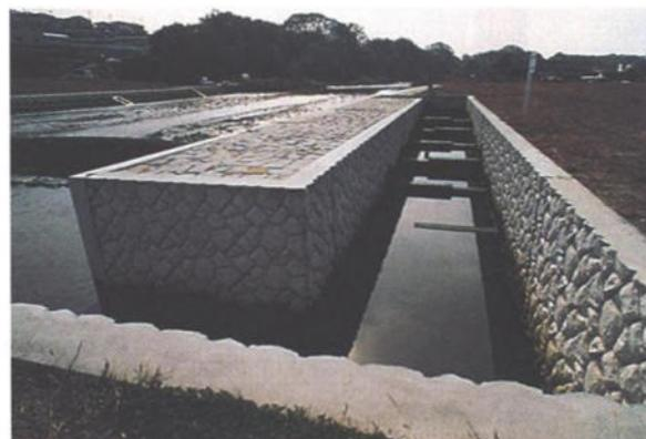
由於橡膠布製起伏堰的魚道離壩稍遠，堰軸和魚道下游端的距離長，易於發生魚道彎曲。
