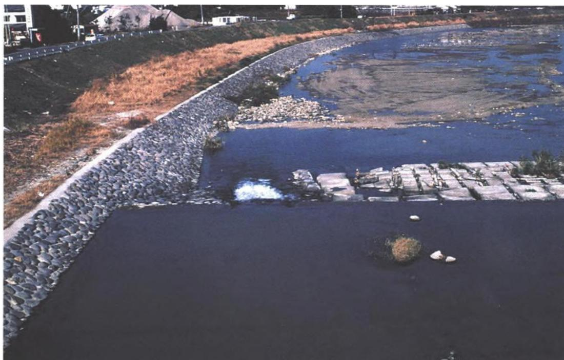
受魚道下游闕止水池的影響，魚道下端與止水池流向之間，形成 S 型的迴流現象。(室見川水系的室見川)
