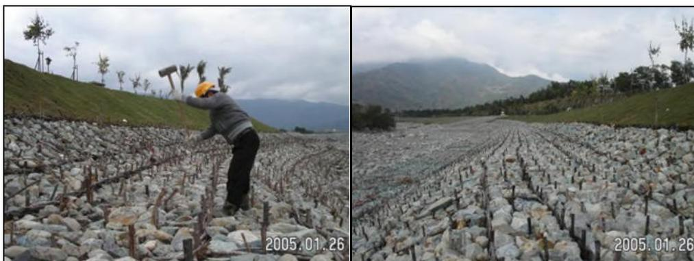
圖九打設活木樁圖十柳枝工完成後全景
