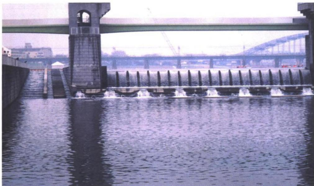
將低水路法線擴大到上下游 200 公尺,魚道築成直線狀的案例。另魚道下游處的保護河床工儘量低築。(多摩川水系多摩川二領宿河原堤堰)
