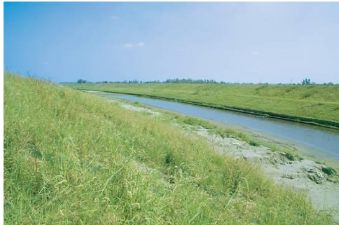
相片 4-26 護坦工與河床形成高低落差
