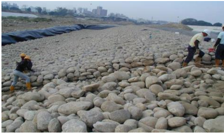
相片4-12 蛇籠護坡工施工中
