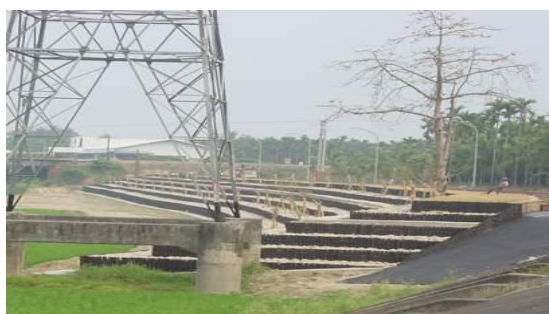
相片4-19木樁工施工中
