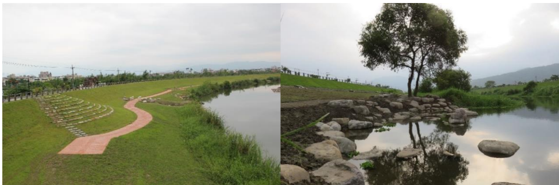
相片2-6堤防堤坡設計緩坡化、自然化
