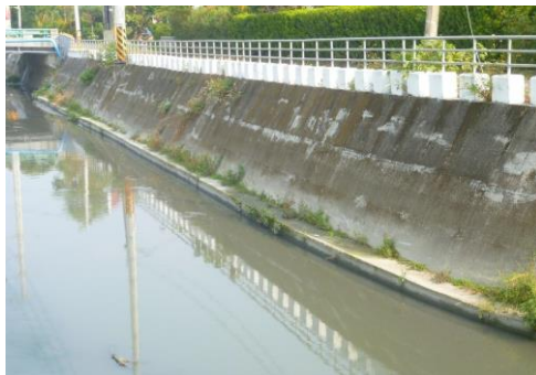
相片 4-7 未設置排水器 相片 4-8 未依規範規定設置排水器
