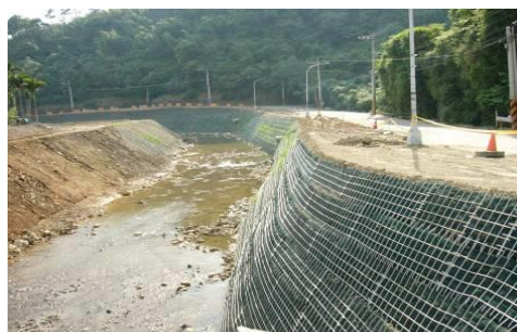
相片4-18湳仔溝溪加勁工法
