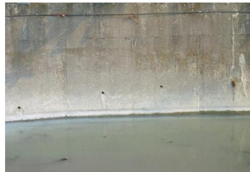
相片 4-7 未設置排水器 相片 4-8 未依規範規定設置排水器
