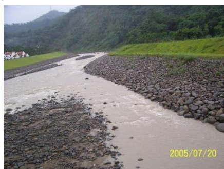
相片4-11 東埔蚋溪護岸排塊石
