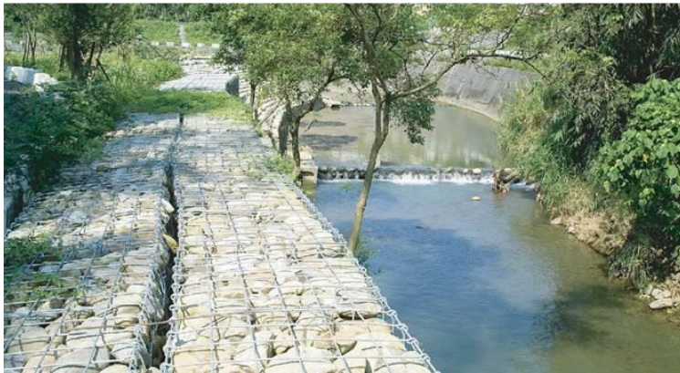
相片4-16 隘寮溪坪頂鋼柵石籠工
