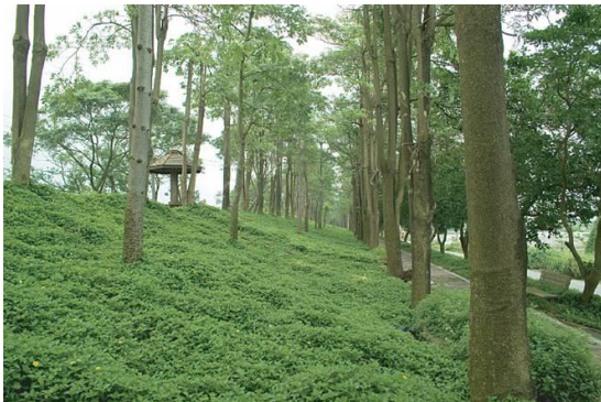
相片2-11 高屏溪萬丹堤防
