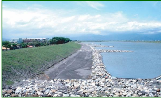
相片 4-27 蘭陽溪五結堤防拋石護坦工
