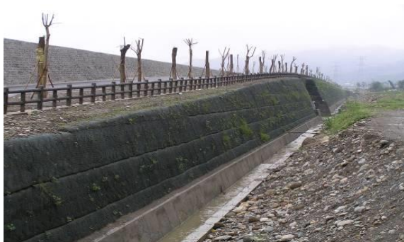
相片4-17東埔蚶溪加勁工法
