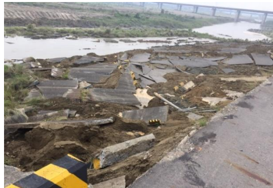
相片 4-6 日新護岸滑動破壞情形
