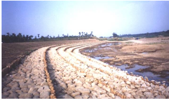
相片4-21竹樁工施工中
