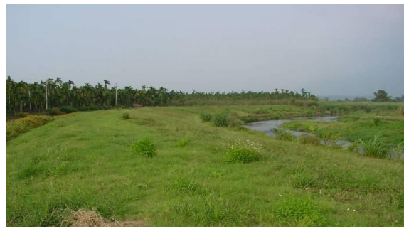
相片4-22竹樁工完工後
