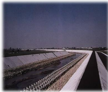
相片4-7混凝土坡面工
