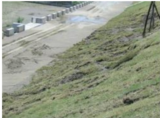
相片3-5草條沿等高線鋪設(正確) 相片3-6草條順坡向鋪設(不正確)
