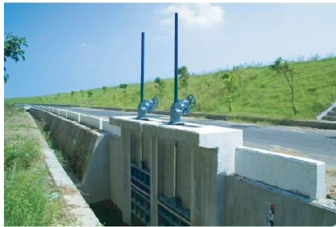
相片1-1 堤防(堤內照片)
