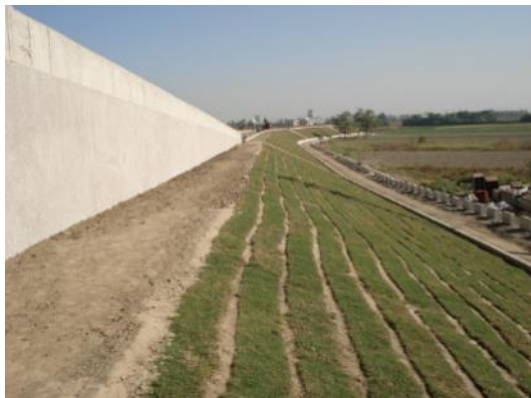
相片3-5草條沿等高線鋪設(正確) 相片3-6草條順坡向鋪設(不正確)
