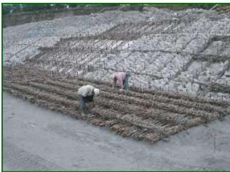
相片 4-29 木梢沉床護坦工(施工中)相片 4-30 木梢沉床護坦工(完工後)
