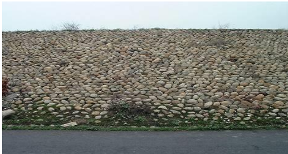
相片4-8 烏溪堤防乾砌塊石
