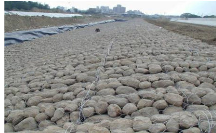
相片4-13 蛇籠護坡工完工後
