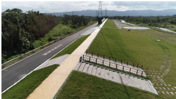
相片1-2堤防(堤防全景)
