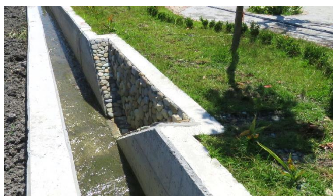
相片 4-32 水防道路側溝設置生物上下坡道
