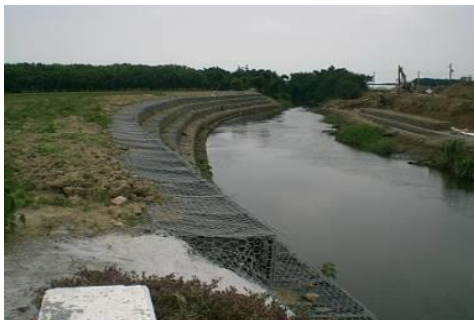
相片4-14 將軍溪排水石籠工
