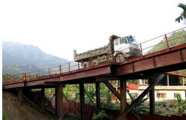
相片 5-4 施工便道採棧橋式
