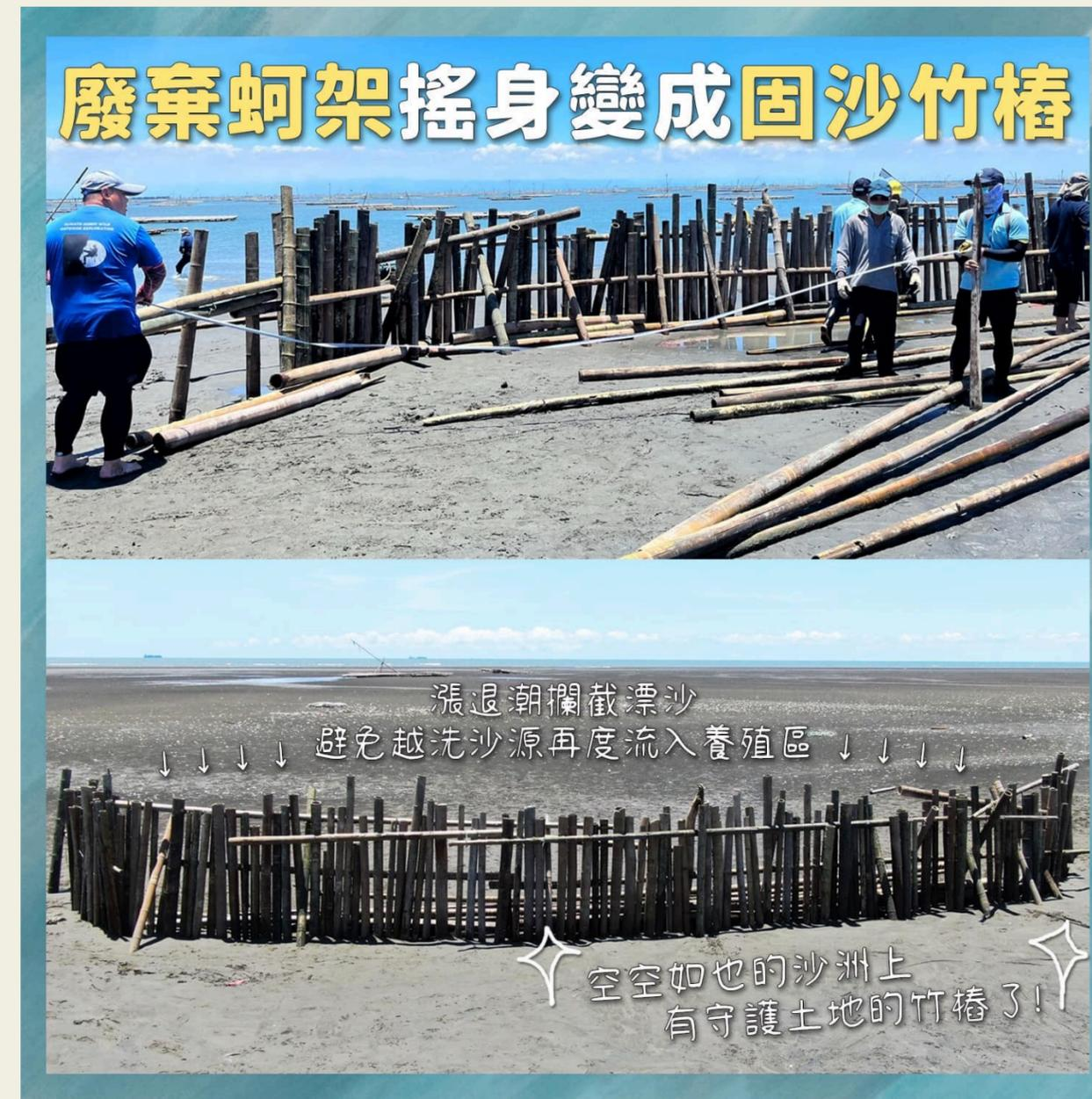
由蚵農協助蒐集廢棄蚵棚、拆解、裁切、鑽孔，作為定沙設施實作材料
