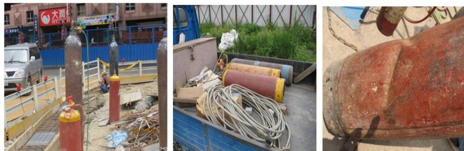
◎鋼瓶直立或倒置使用未固定且未裝防回火裝置 / 鋼瓶變形。
