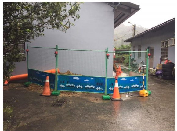
施工照片：工區安全圍設
