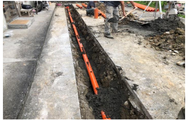
施工照片：管線埋設
