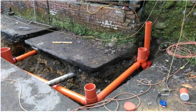
施工照片：管線埋設
