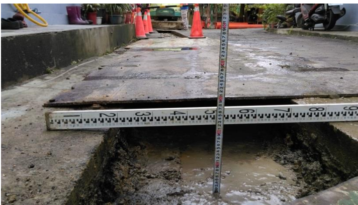
施工照片：瀝青混凝土臨鋪鋪面，厚 20cm
