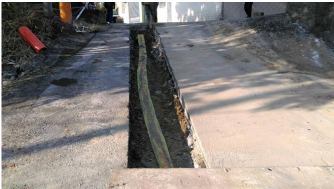
施工照片：管線警示帶
