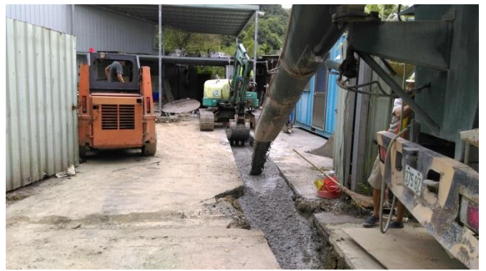
施工照片：混凝土澆置
