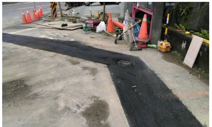
施工照片：瀝青混凝土鋪面
