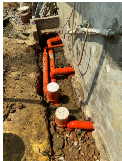
施工照片：用戶接管埋設及連接
