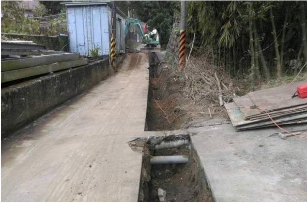
施工照片：管溝開挖
