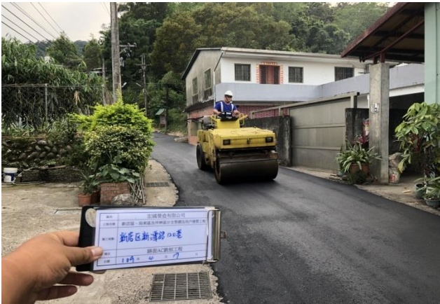
施工照片：瀝青面層鋪築
