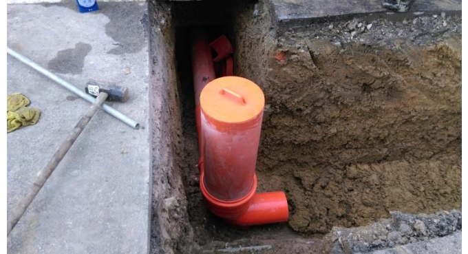
施工照片：陰井埋設
