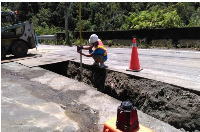
施工照片：雷射測量儀量測
