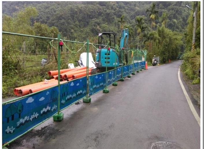
施工照片：工區安全圍設
