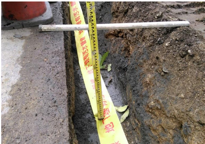
施工照片：管線警示帶
