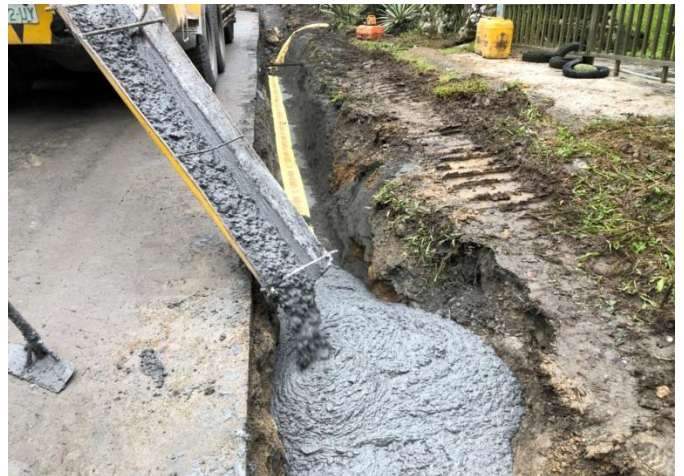
施工照片：CLSM 澆置
