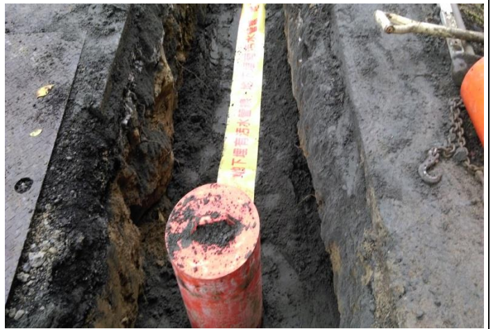
施工照片：陰井埋設
