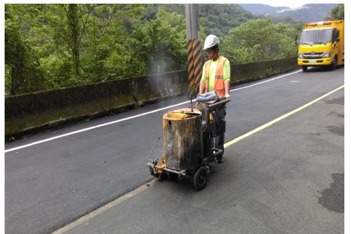
施工照片：熱拌反光標線繪製
