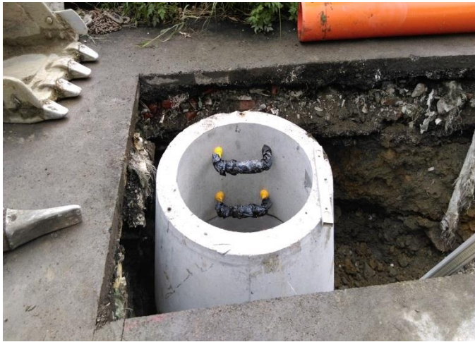
施工照片：人孔埋設
