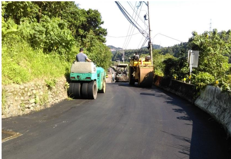
施工照片：瀝青面層鋪築
