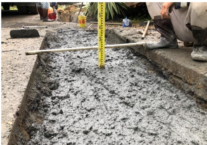
施工照片：瀝青混凝土臨鋪鋪面，厚 20cm
