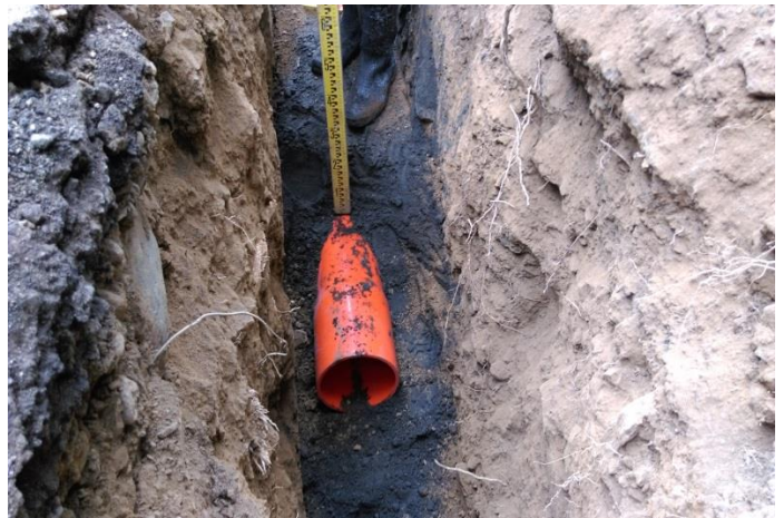
施工照片：管線埋設
