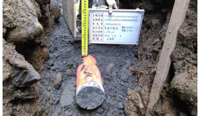
施工照片：回填砂(管頂)
