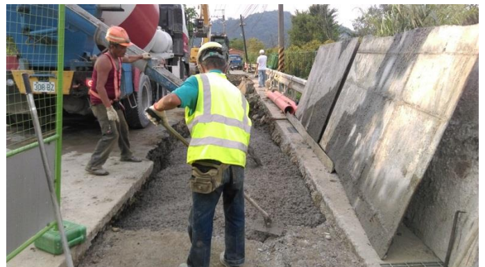
施工照片：CLSM 澆置
