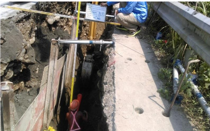
施工照片：管線埋設(管頂)
