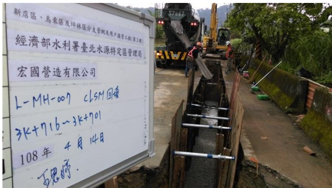
施工照片：擋土設施
