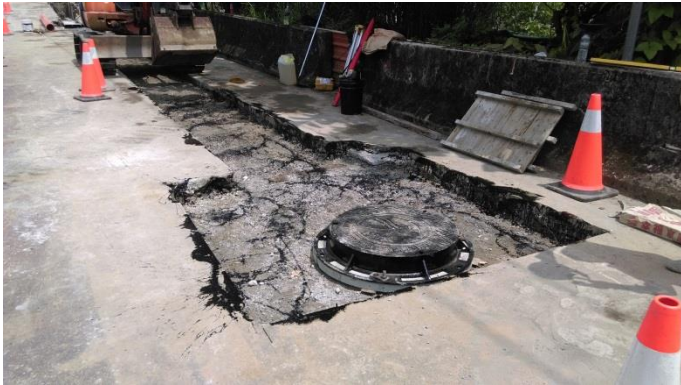
施工照片：人孔蓋及蓋座
