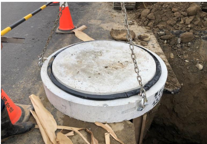
施工照片：擠壓式填縫帶
