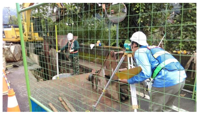
施工照片：施工測量
