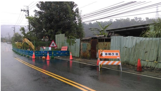
施工照片：施工圍籬，移動式，含臨時照明
