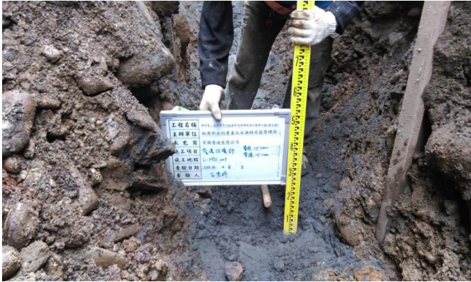
施工照片：回填砂(管底)
