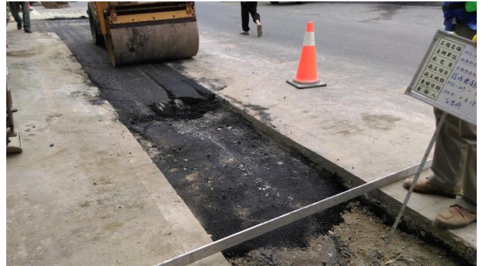
施工照片：瀝青混凝土鋪面，厚 20cm
