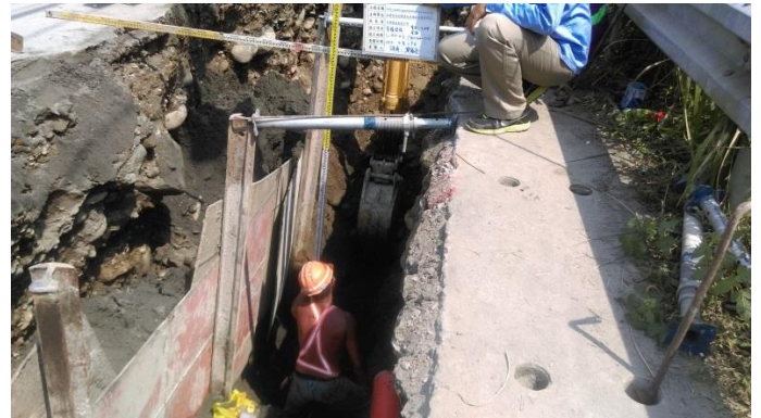
施工照片：管線埋設(管底)
