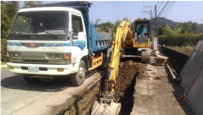
施工照片：管道開挖、運棄
