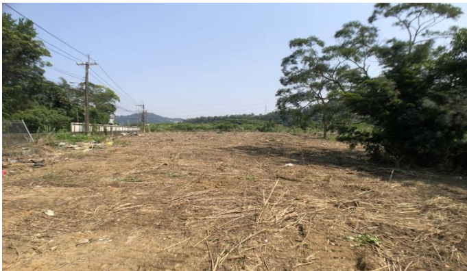
施工照片：材料堆置場
