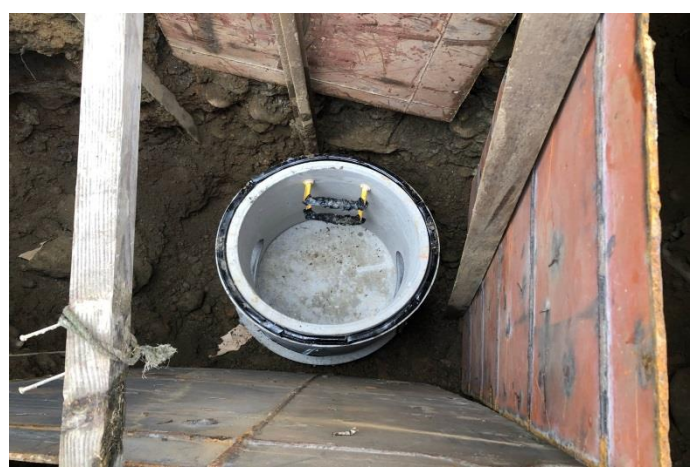
施工照片：人孔埋設
