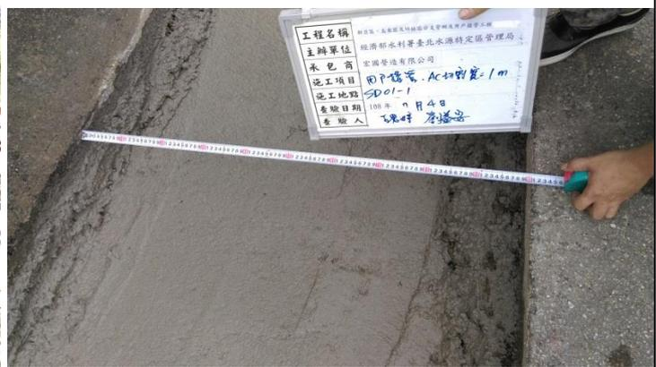
施工照片：管溝開挖寬度量測
