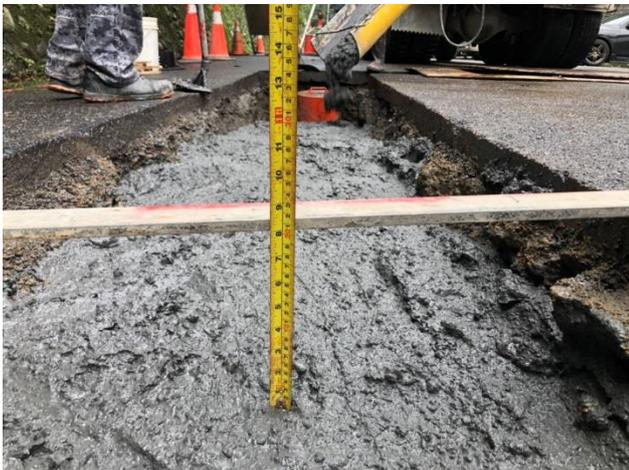
施工照片：瀝青混凝土臨鋪鋪面，厚 20cm
