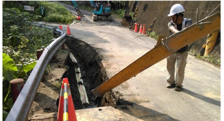
施工照片：CLSM 澆置
