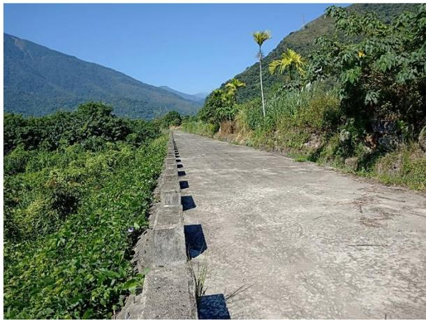
華隆護岸現況照片（全段狀況相似），預計堤外緩坡化、種植原生植物綠化並移除外來入侵植物
