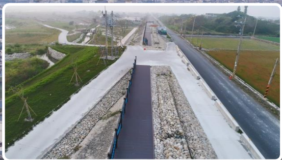
1.越堤路改善1處
