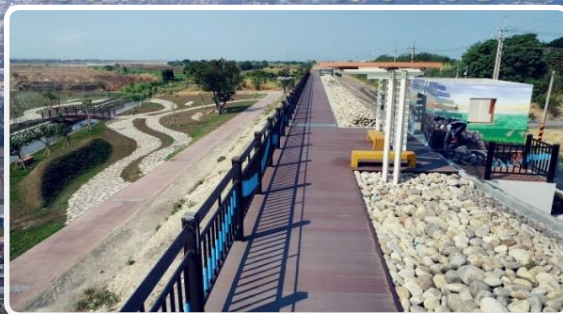
3.棧道工程212.7公尺、崗哨站周邊改善
