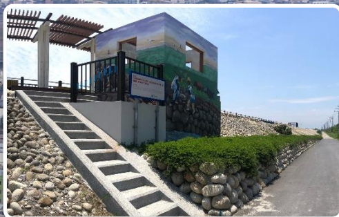
2.水防道路改善240公尺
