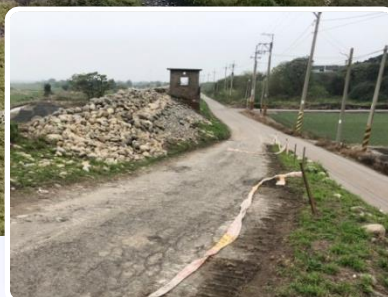
既有崗哨站、越堤路
