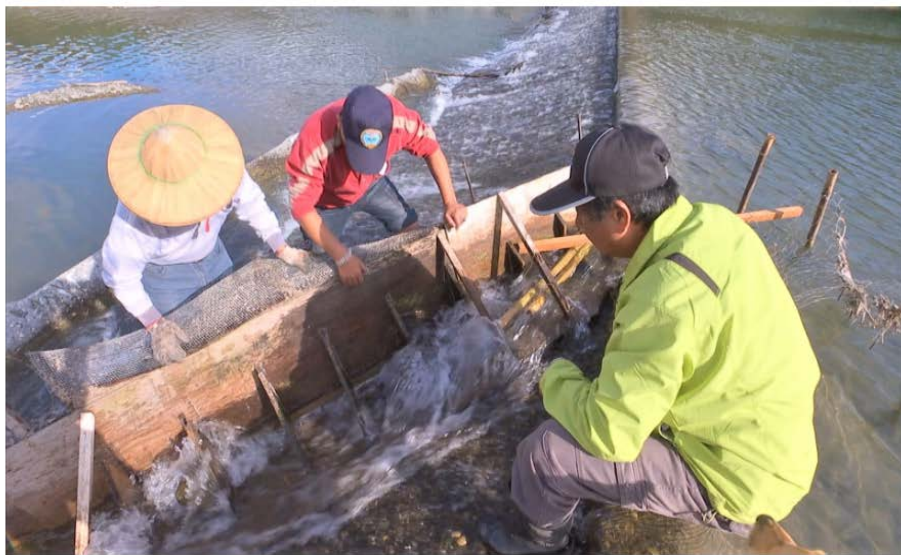
模組化的簡易魚梯，隨時可視狀況移動。
