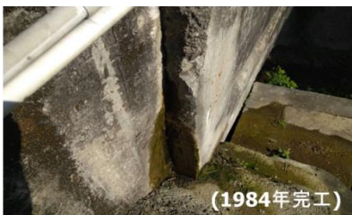
永和山引水路老舊破損漏水
