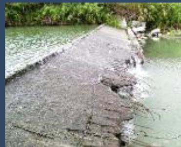
潭浦堀野溪與鰲溪匯流口攔河堰掏空，水泥結構破損鋼筋大量裸露，影響魚類洄游。
