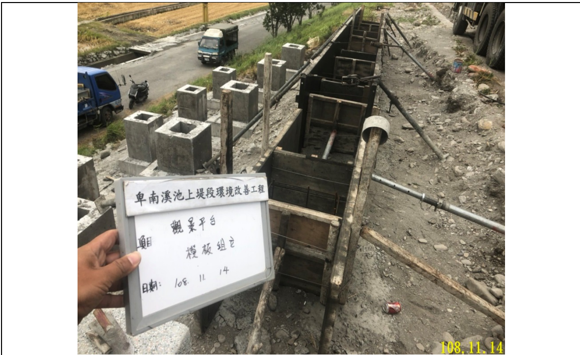
觀景平台完工後須注意空間連貫性
