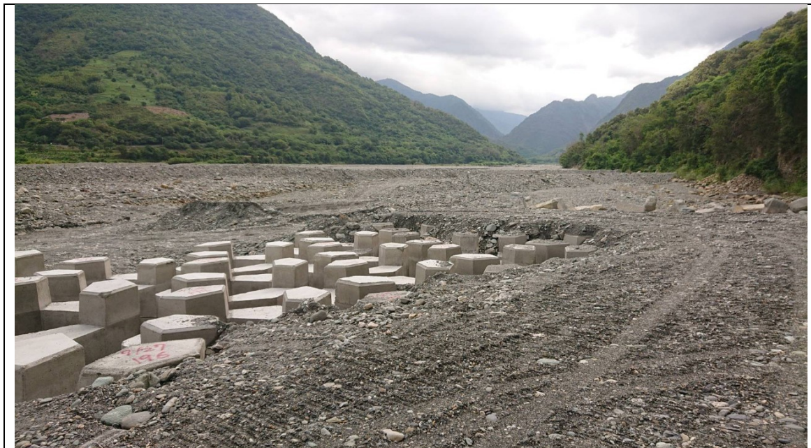
廣原堤段丁壩工後方目前已回填完成，然丁壩宮前方仍須注意意避免造成橫向不連續面產生
