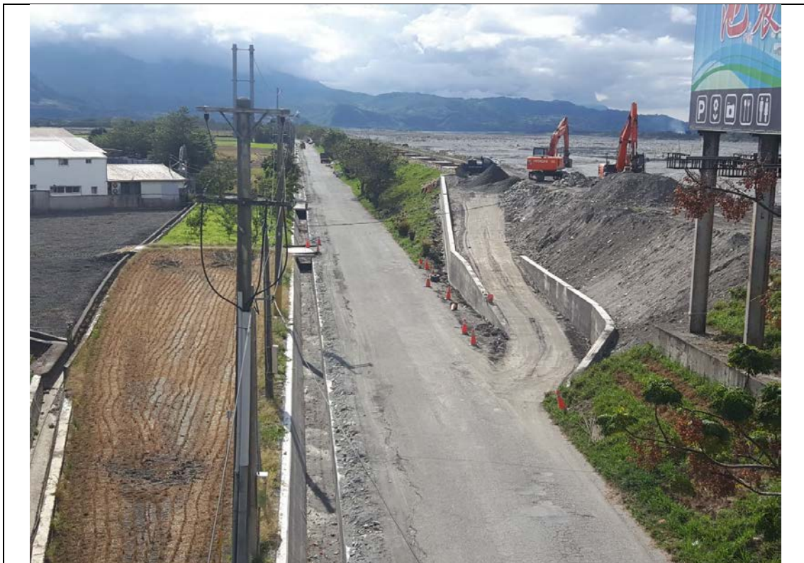
池上堤段部分，目前僅剩堤頂道路其餘皆已完工，完成面需注意避免造成橫向不連續面產生
