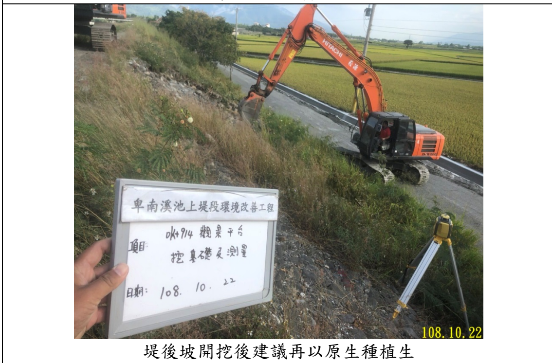
池上堤段部分，目前僅剩堤頂道路其餘皆已完工，完成面需注意避免造成橫向不連續面產生
