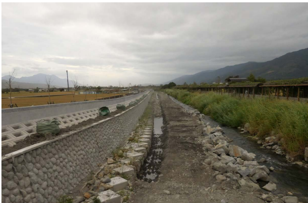
施工時需控制施工開挖面避免大規模開挖
