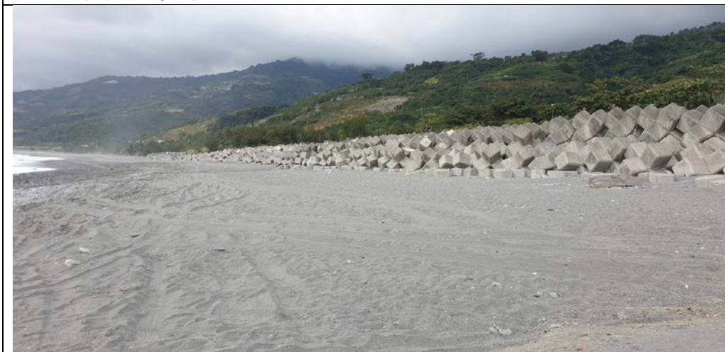
靠近海堤部分，堤前堆置混凝土塊
