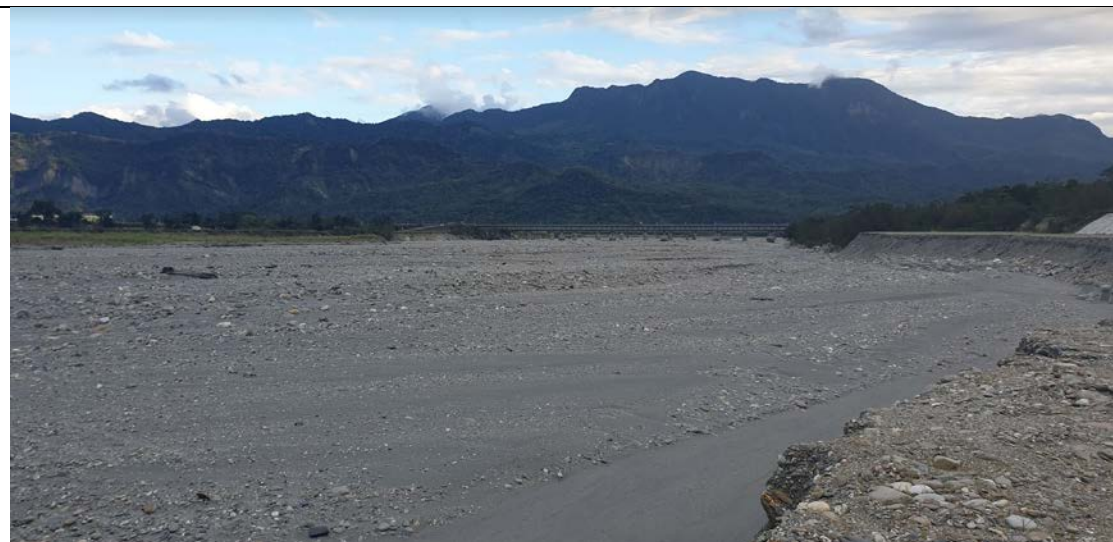
鹿寮溪河道現況
