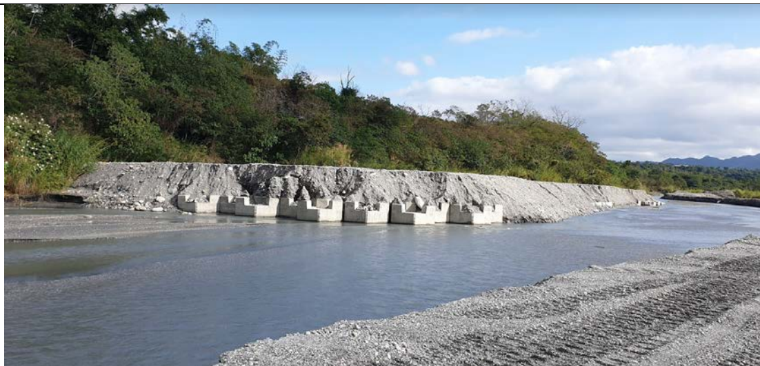
鹿鳴工區現況 1
