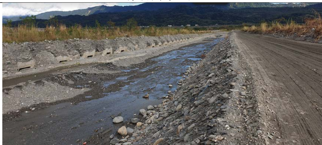
加鹿溪河道現況
