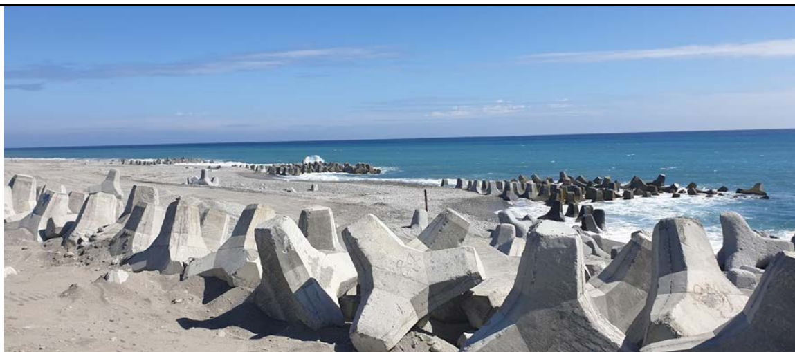
說明：豐里海岸工區新設三座突堤，已完工。
