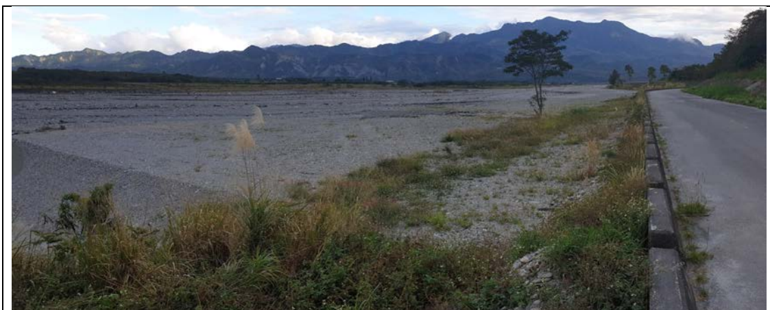
鹿寮溪武陵護岸丁壩工現況
