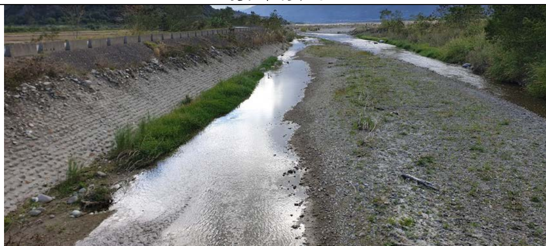
萬安溪河道工現況
