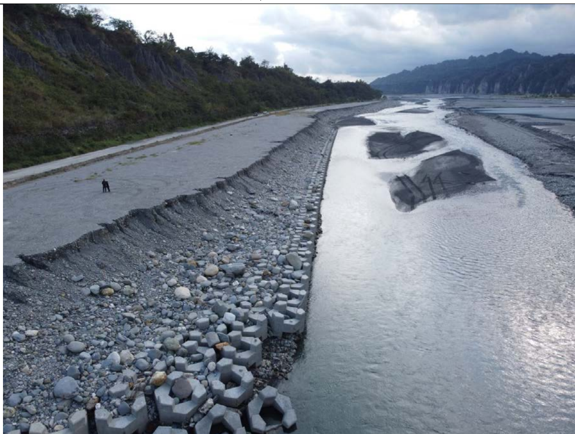
利吉工區現況
