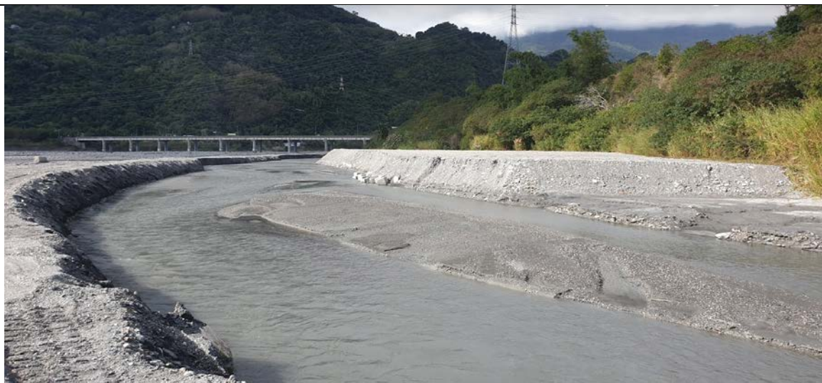
鹿鳴工區現況 2
