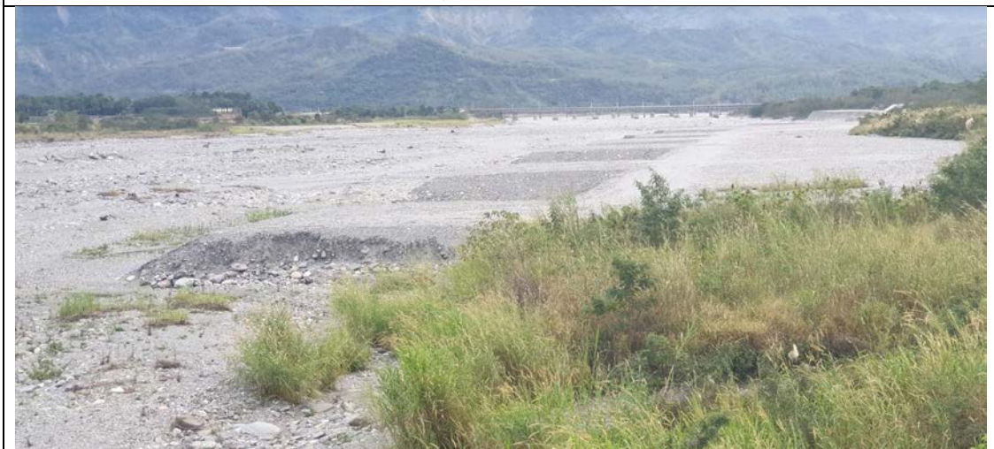
鹿寮溪永隆護岸丁壩工現況
