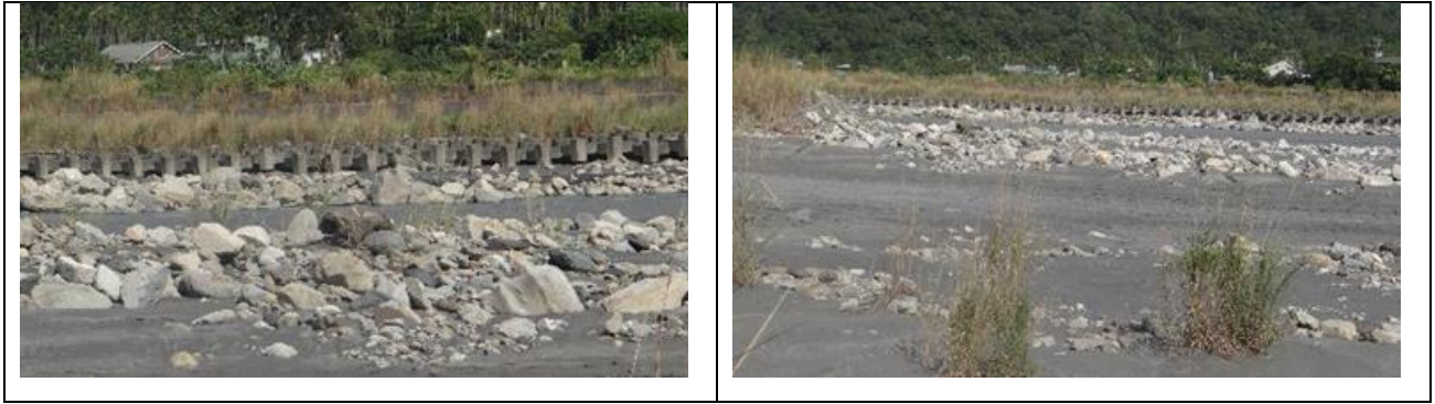
圖 4-2 濁水溪雙龍護岸及拔社埔堤防段現況圖
