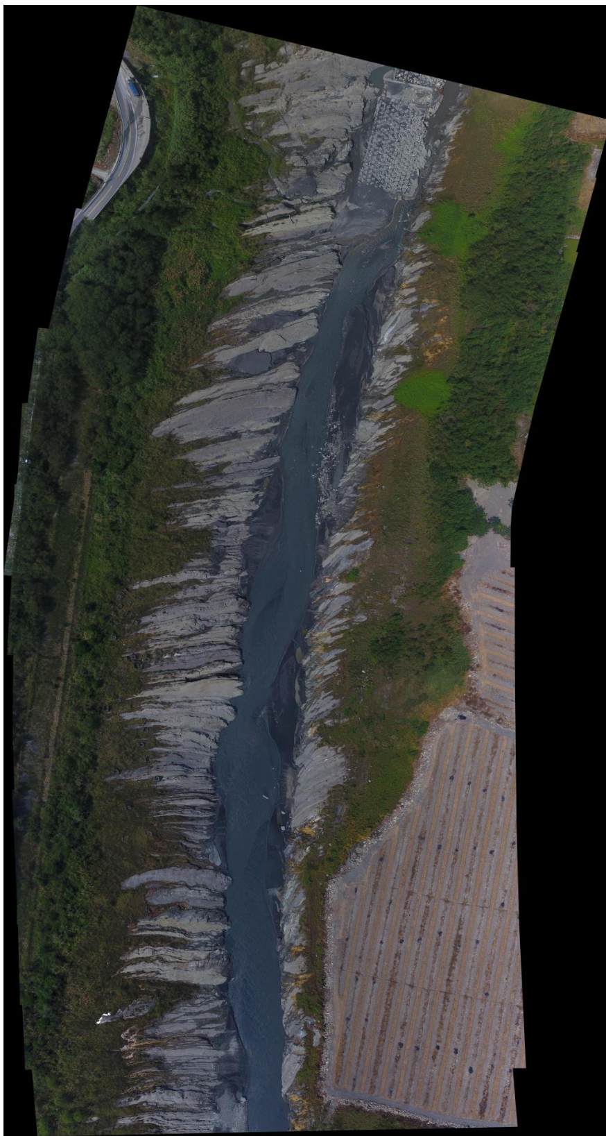
圖 4-19 濁水溪富州堤段(113 斷面)防災減災工程正射影像圖
