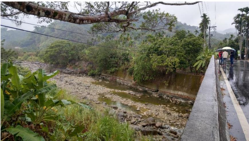
圖 3-12 樟平溪計畫區域石籠(下游)與混凝土護岸照片
