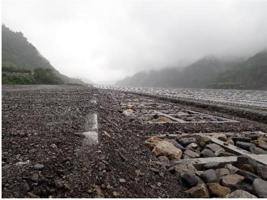
圖 2 已回填塊石之格框式護坦
