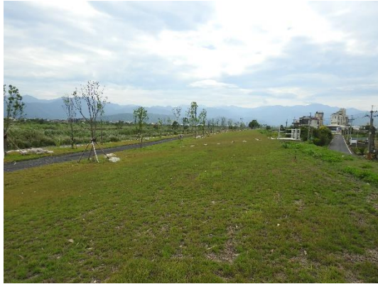
圖 2 石階看台預定地現況
