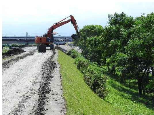
施工中(109.06.12)前坡雀榕已被移植
