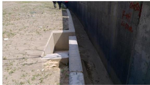
照片 8：施工後側溝生物逃生通道設置
