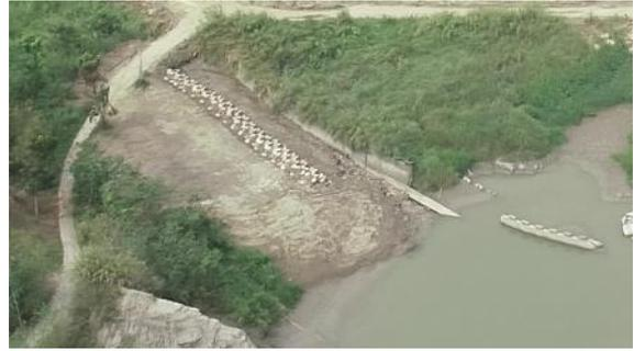
照片 6：支流水路坡腳保護工程施工情形
