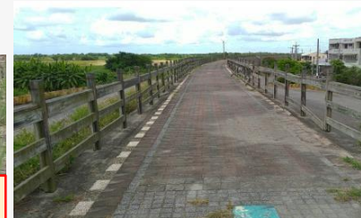
預定工程堤防現況
