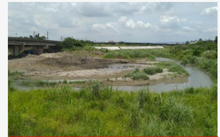
下游河段河道現況
