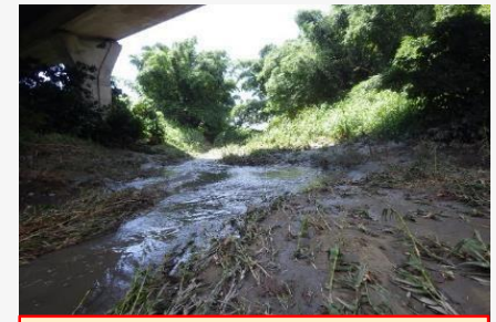
下游河段河道現況
