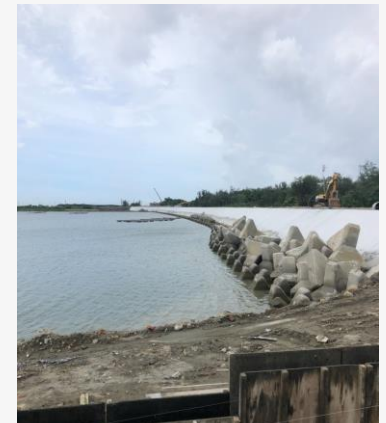
海堤外側現況
