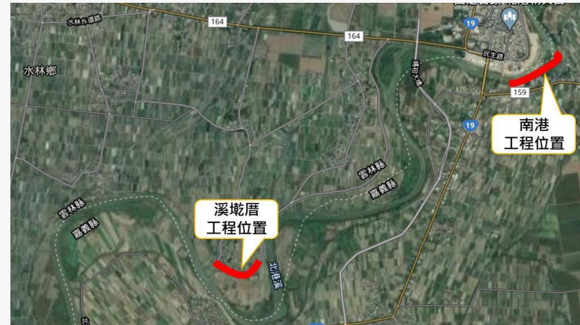
北港溪南港、溪墘厝堤段環境改善工程
