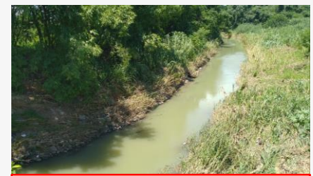
下游河段河道現況
