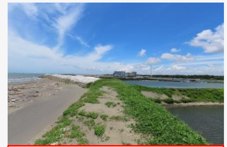
外側海堤海域現況
