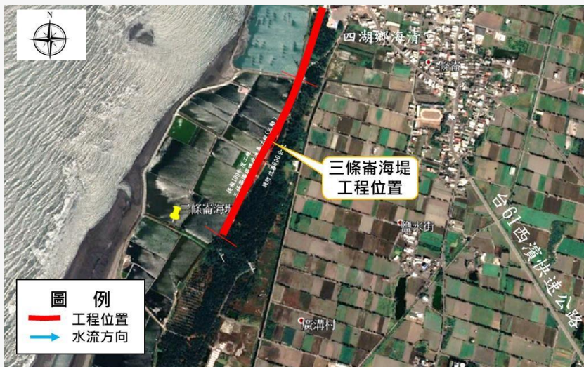
雲林縣三條崙海堤環境改善工程
