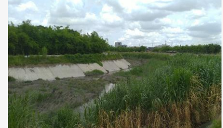
下游河段河道現況
