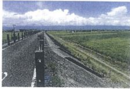
施工中環境照片(110.06.10)
