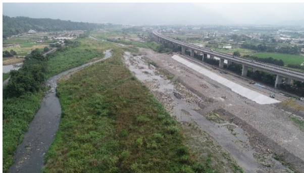
(工程設施空拍照)
