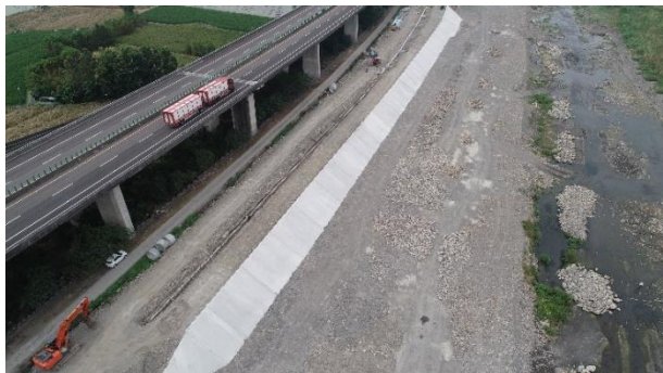
(工程設施空拍照)
