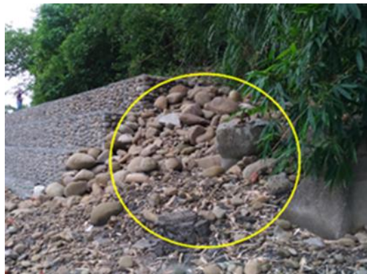
圖 3、堤前、堤尾整理緩坡化參考圖
