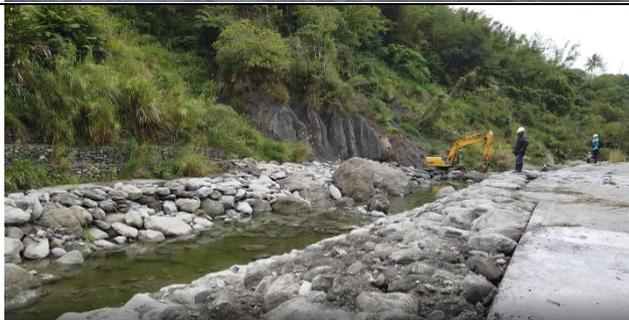
工程起點處防砂壩下方的塊石已完成全斷面的鋪設與水密施作，現勘當日沒有斷流的狀況
