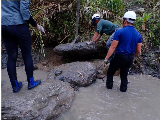
石梁固床工施作，在縫隙處以人工填塞小的塊石以協助大塊石的穩定
