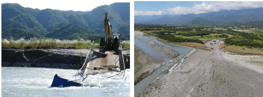
圖 5.2.2-2 花蓮溪山尾堤段疏濬工程排擋水執行情形
