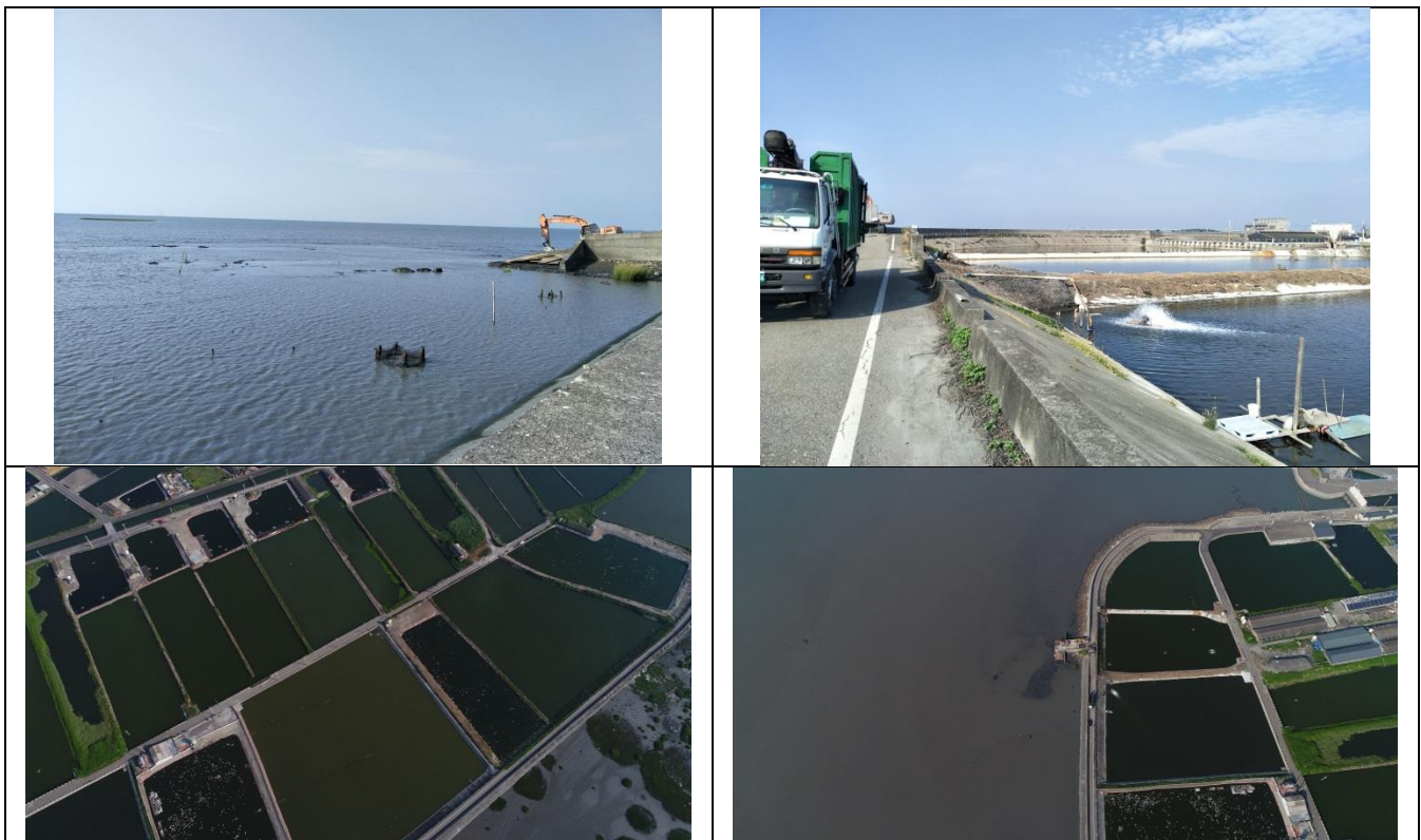
圖 4-147 大城南段海堤工區現況照
