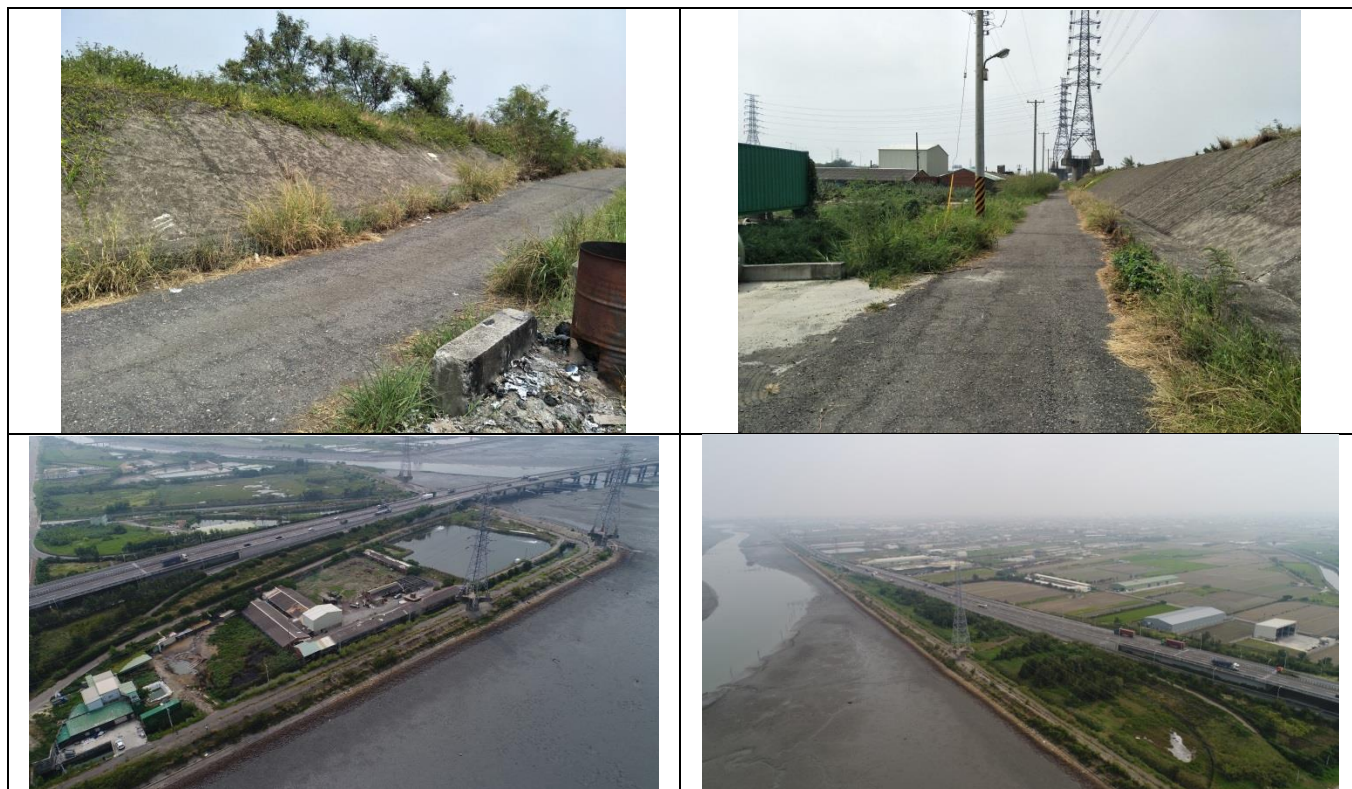
圖 4-149 崙尾南段海堤工區工程現況照
