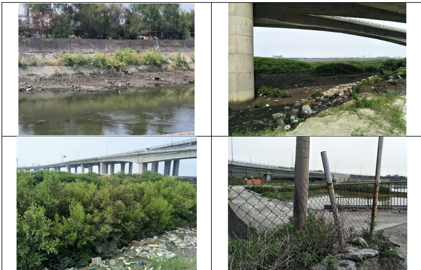
圖 4-148 二港海堤工區工程現況照
