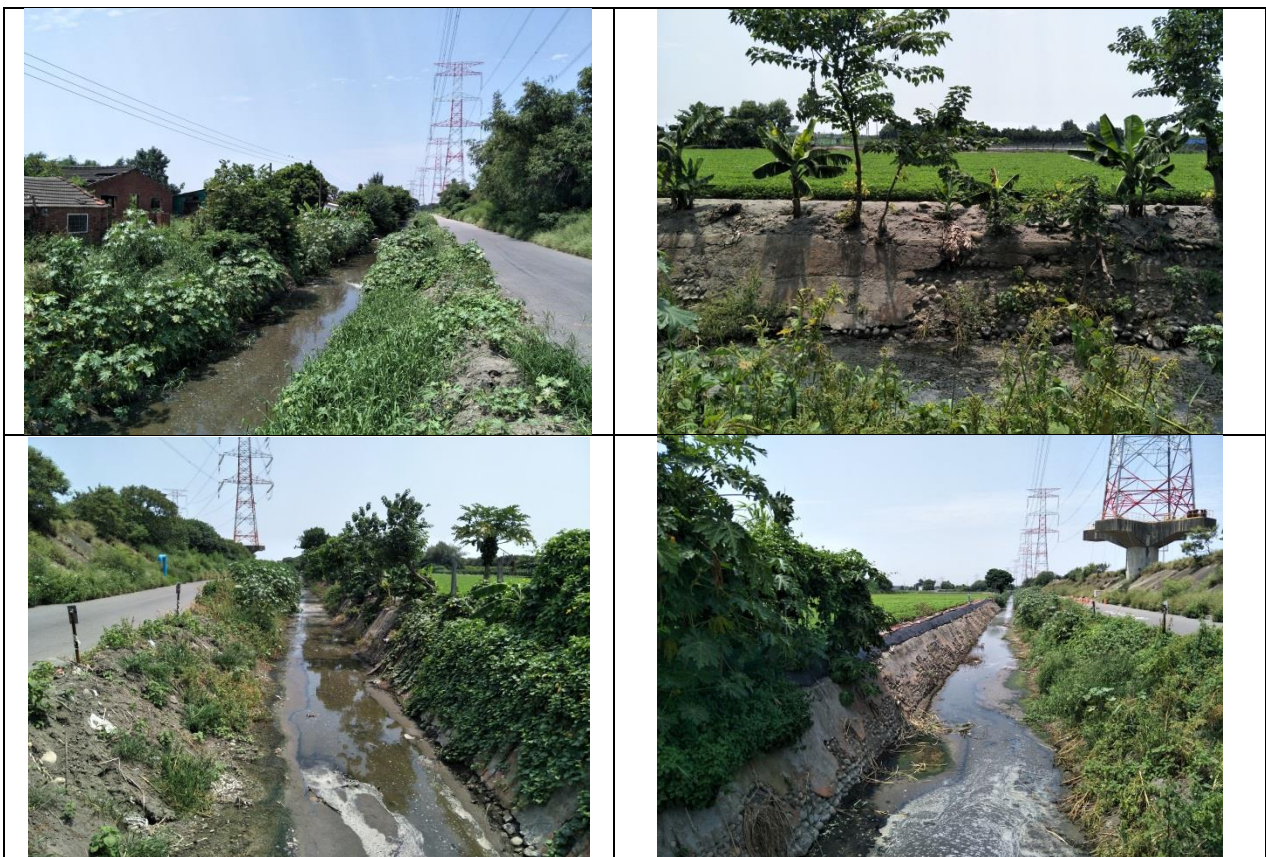
圖 4-114 110 年度濁水溪雷厝堤段構造物維修改善工程現況圖
