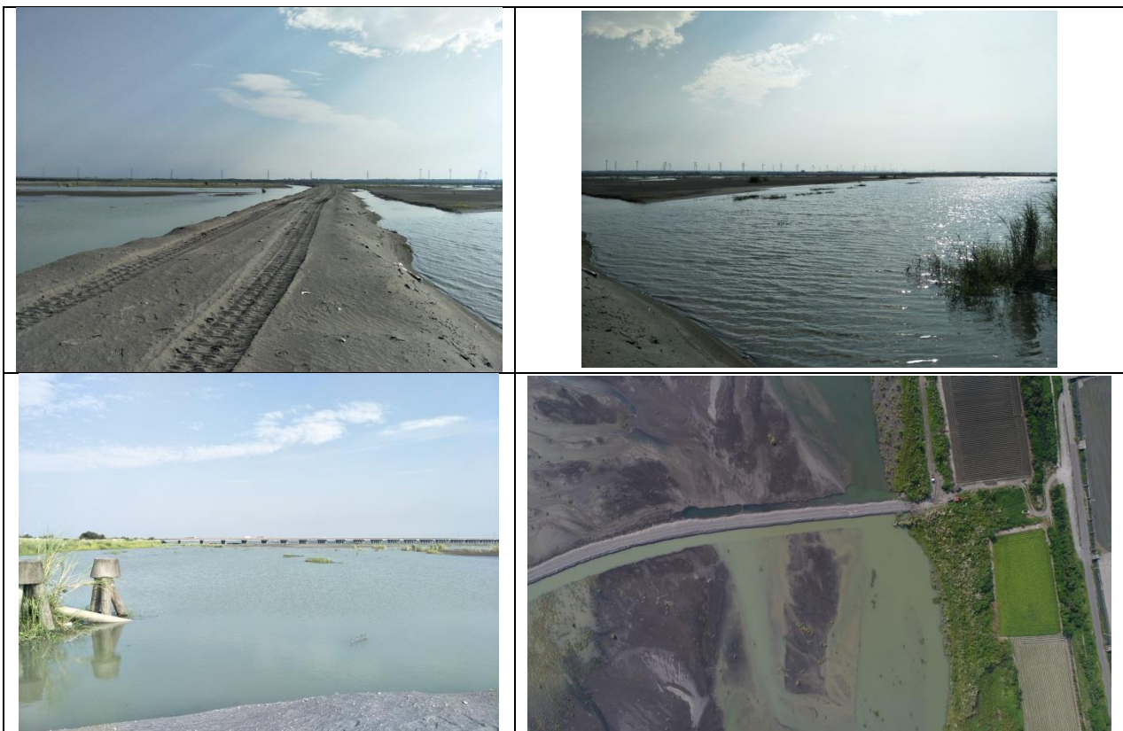
圖 4-120 西濱大橋下游段簡易設施工程現況照
