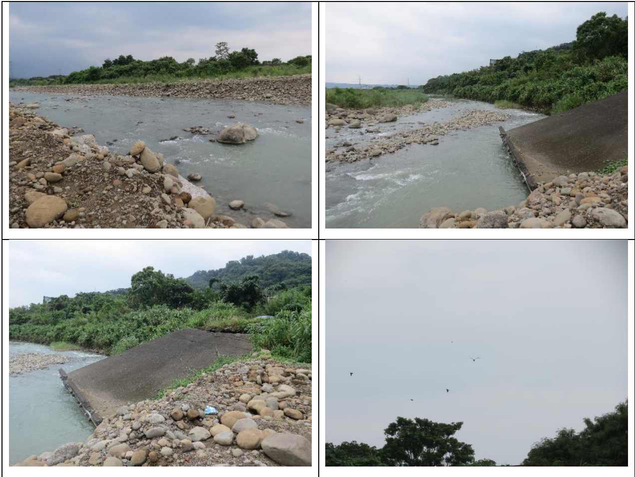
圖 4-50 東埔蚋溪藤湖堤段防災減災工程現況照片
