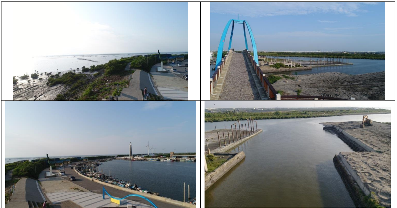
圖 4-130 彰化縣王功新生地海堤堤段整建工程現況照
