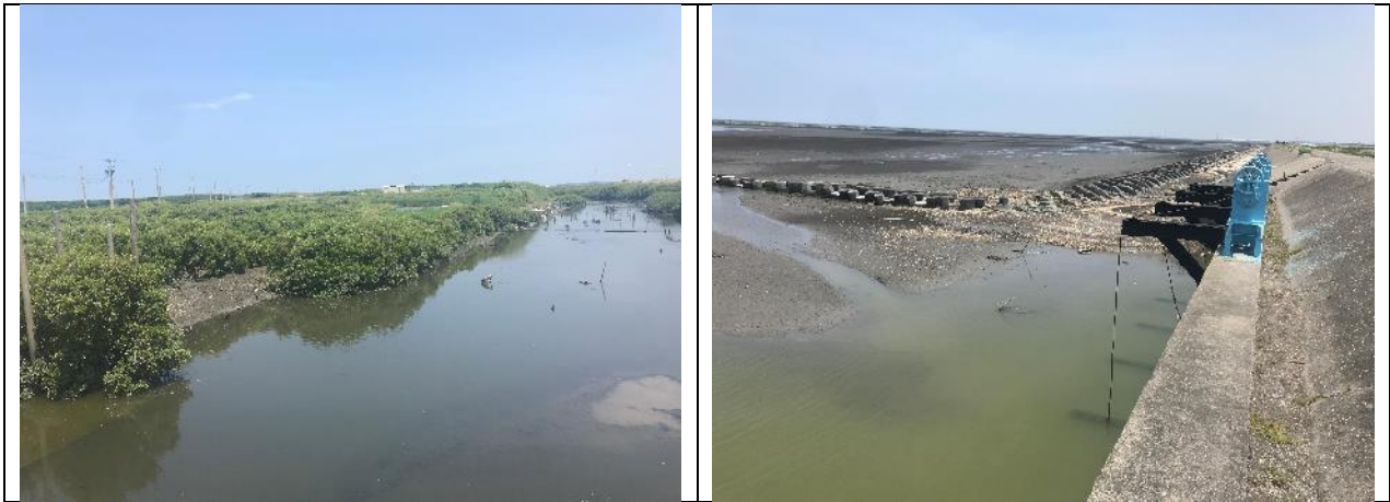
圖 4-110 彰化縣漢寶海堤 44、49 號水門旁防汛道路銜接工程
