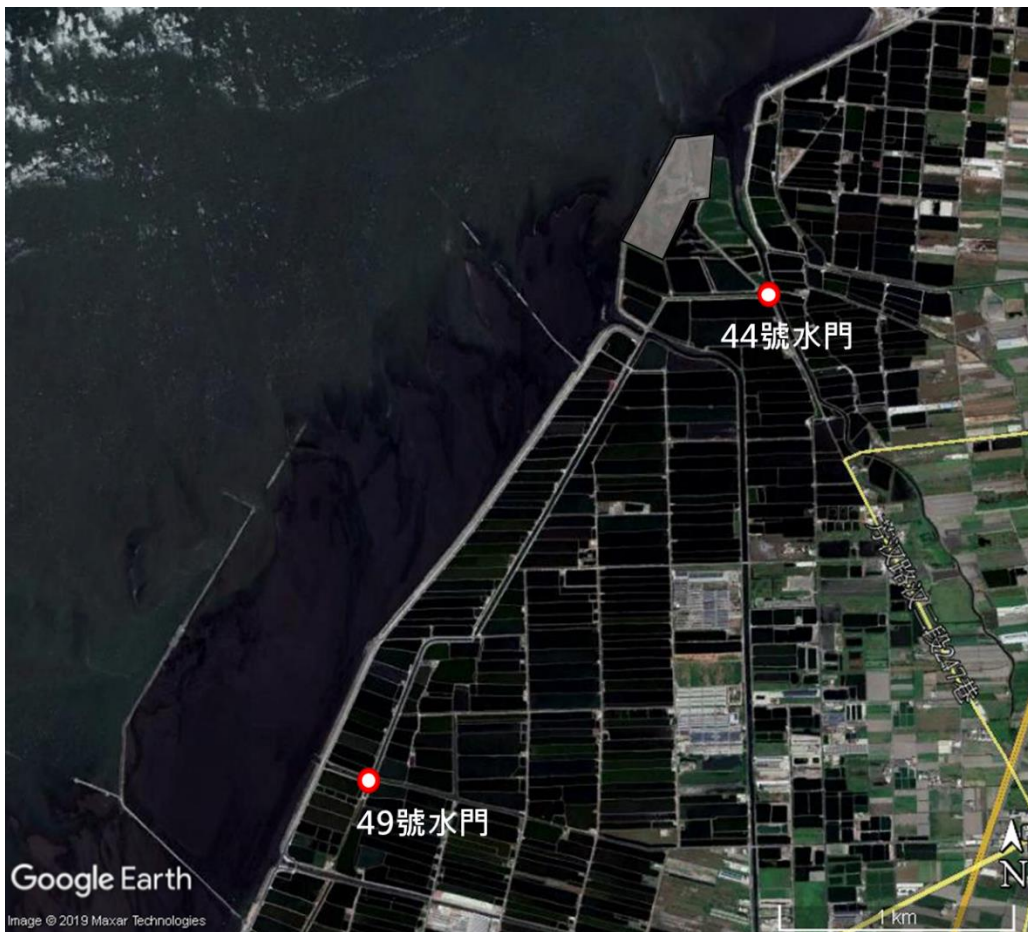
圖 4-109 彰化縣漢寶海堤 44、49 號水門旁防汛道路銜接工程
