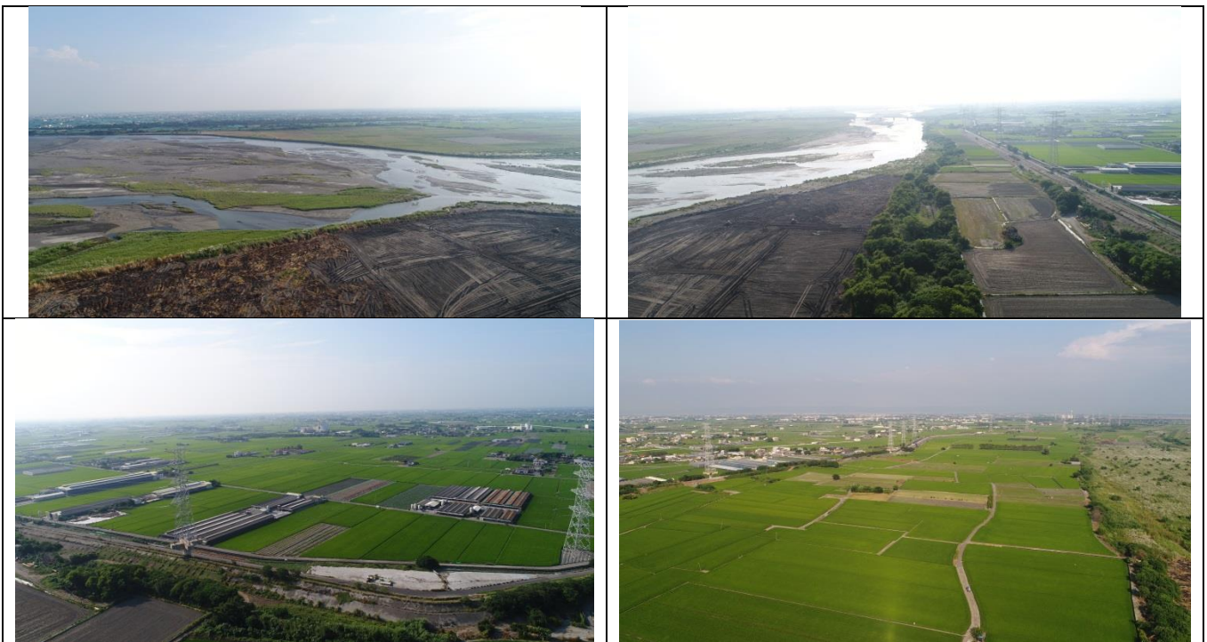
圖 4-138 濁水溪下溪墘堤段(斷面 37~39)整建工程現況照
