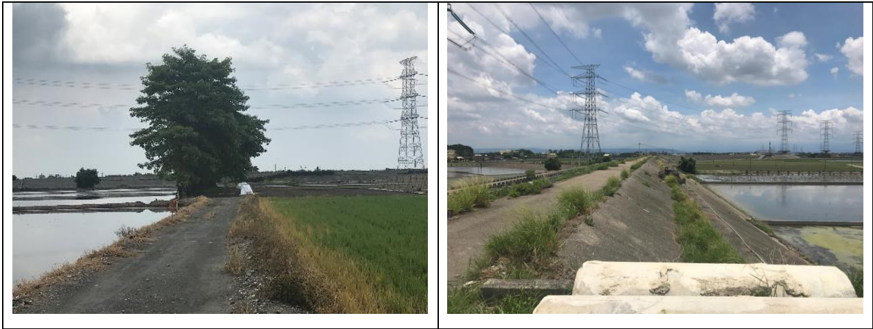
圖 4-30 濁水溪田頭堤防河川環境改善工程現地狀況
