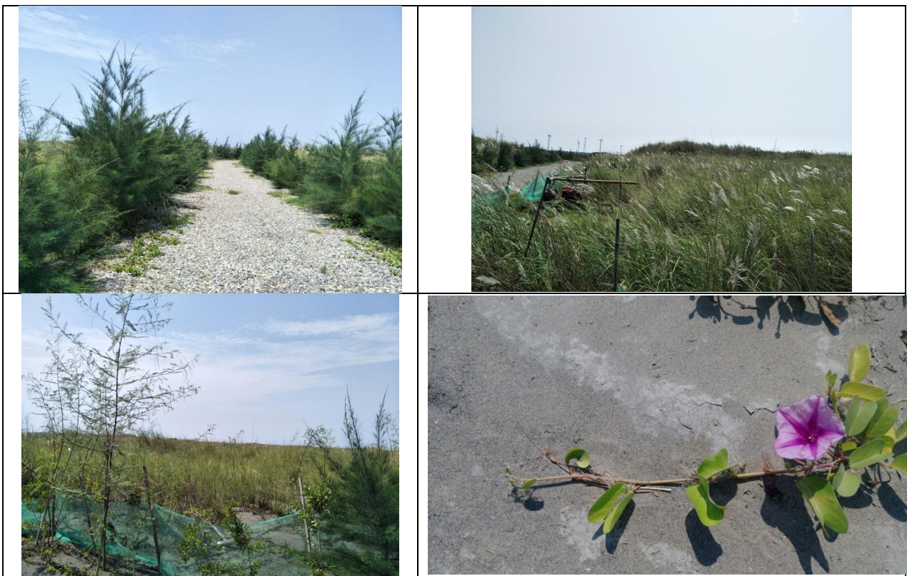
圖 4-122 濁水溪許厝寮堤段整建工程現況照
