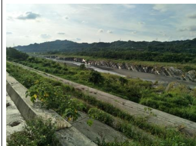
施工下游環境
