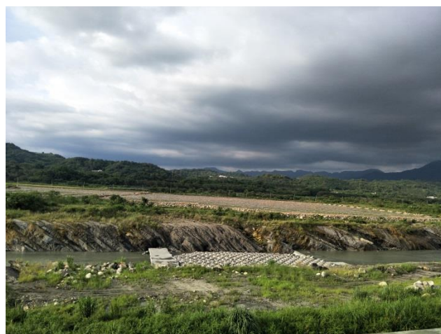
施工附近水域
