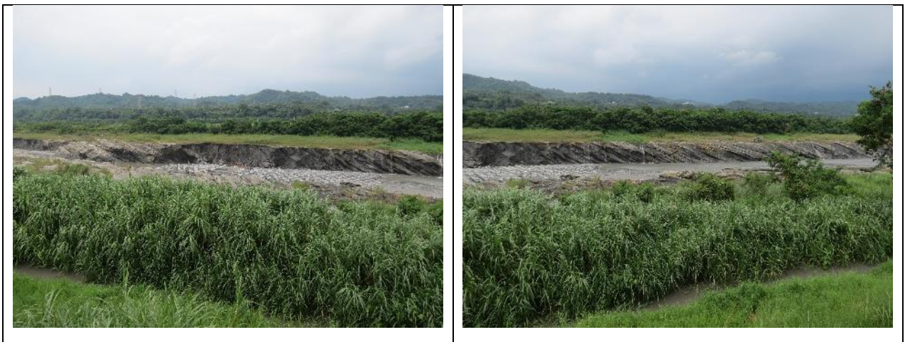
圖 4-21 濁水溪富州堤段(113 斷面)次生林與河岸照片
