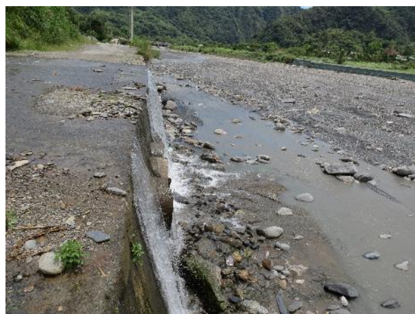
右岸堤防現況
