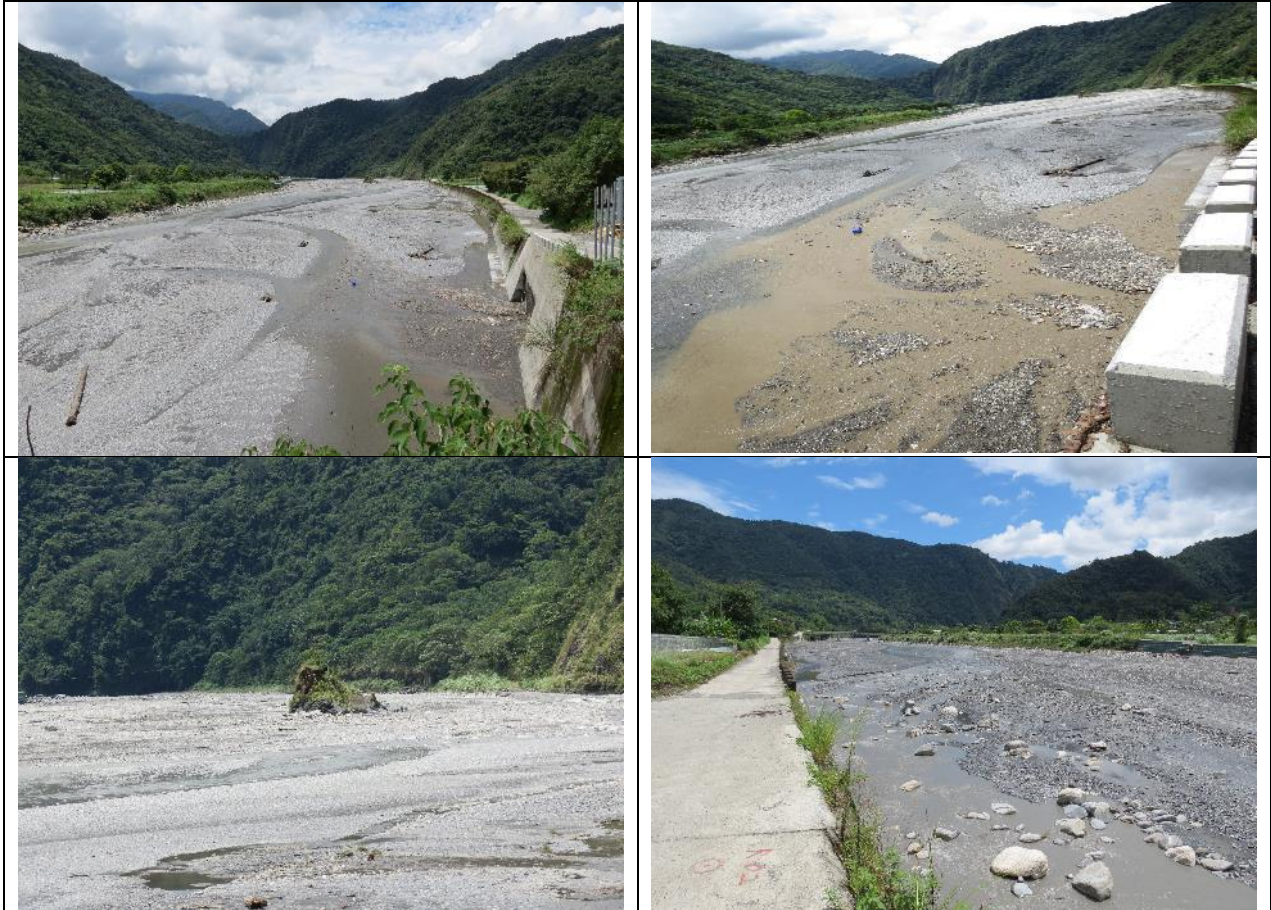
圖 4-56 濁水溪新武界橋下游右岸堤段防災減災工程現況照片
