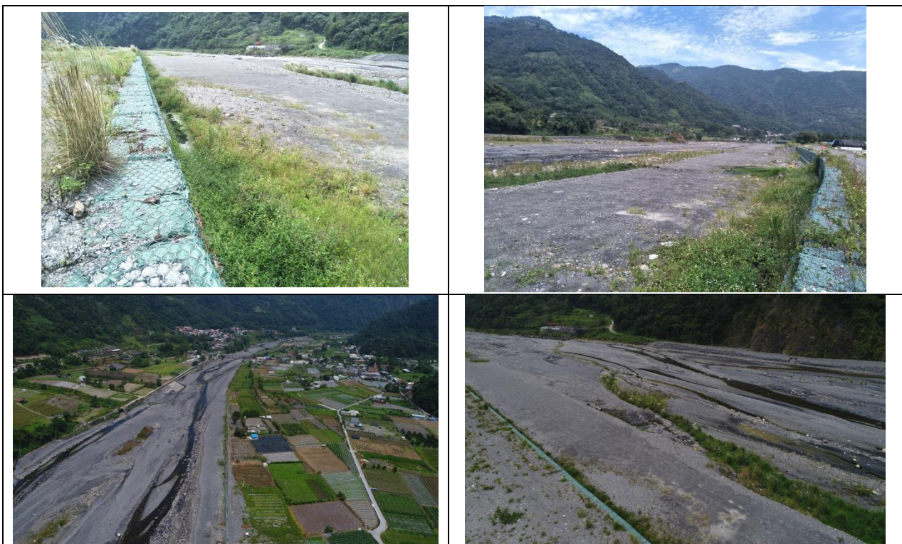
圖 4-124 濁水溪新武界橋下游左岸堤段(0+600~1+100)整建工程現況照
