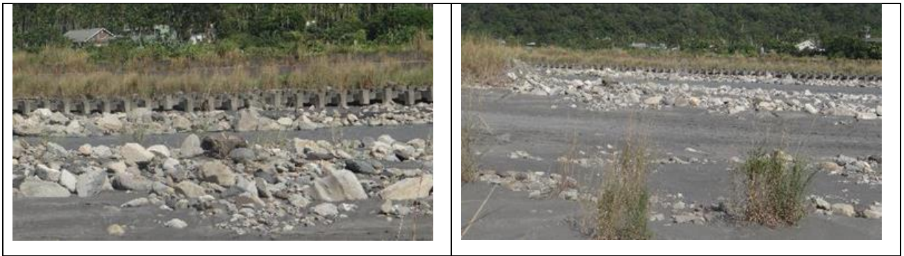
圖 4-38 濁水溪雙龍護岸及拔社埔堤防段現況圖
