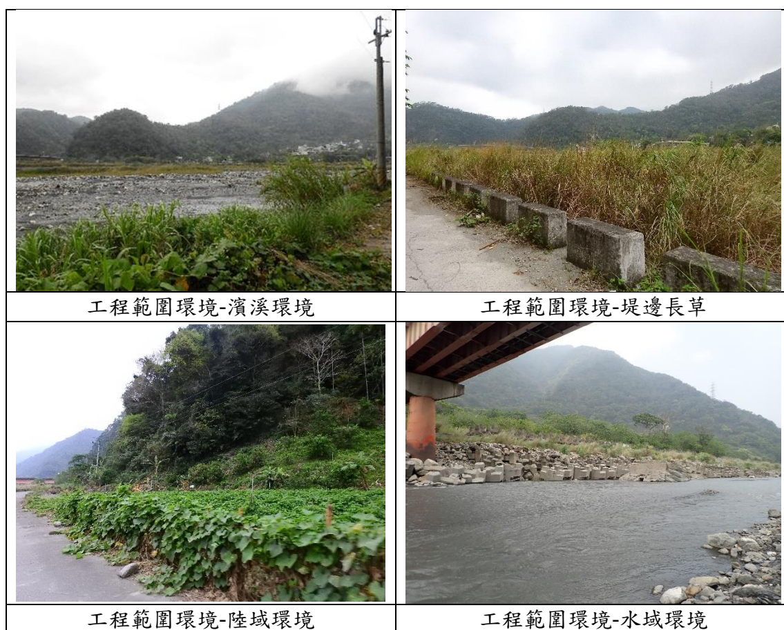
圖 4-40 濁水溪雙龍護岸及拔社埔堤防段防災減災工程環境照
