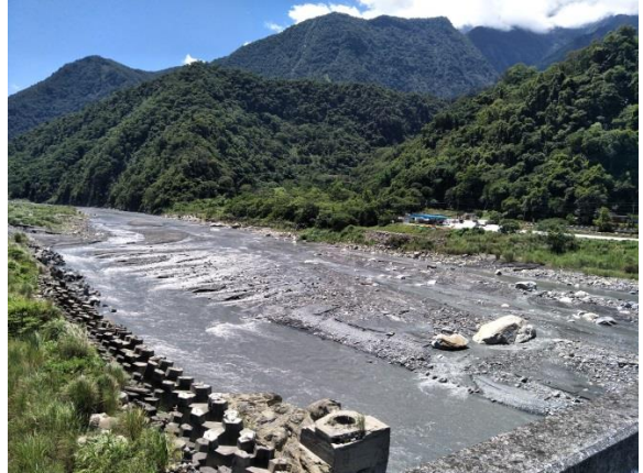
施工水域環境
