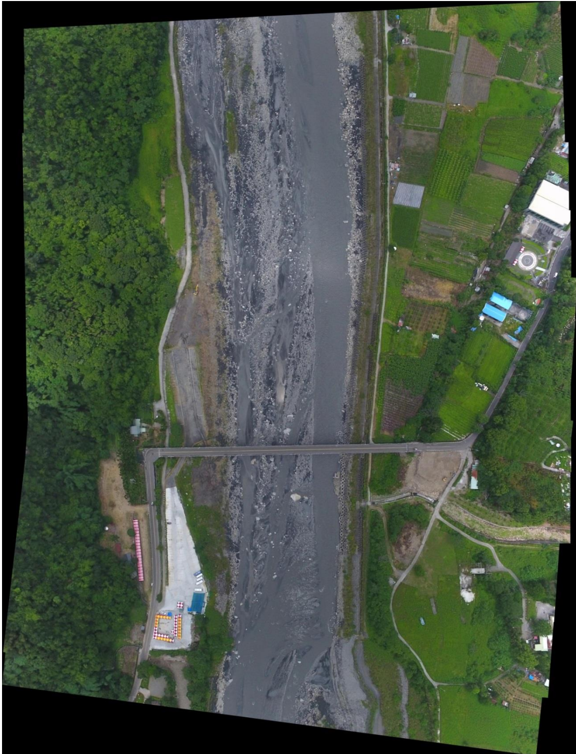
圖 4-44 濁水溪雙龍護岸及拔社埔堤防段防災減災工程正射影像圖
