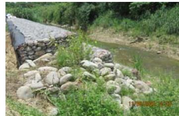
D 工區採通透性高的石籠護岸設計，堤尾緩坡化塊石護坡
