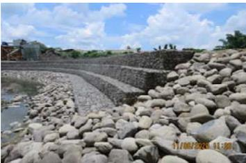
B 工區堤頭堤尾緩坡化塊石護坡
