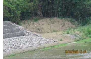
A 工區堤頭堤尾緩坡化塊石護坡
