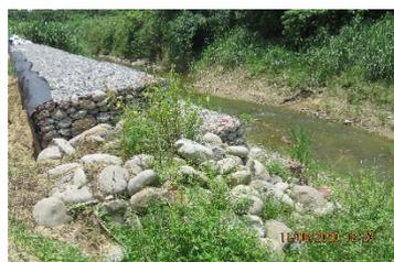
D 工區採通透性高的石籠護岸設計，堤尾緩坡化塊石護坡
