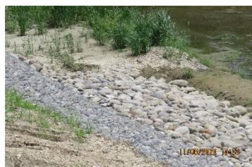
A 工區堤頭堤尾緩坡化塊石護坡
