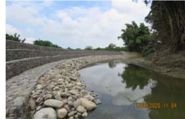
B 工區採通透性高的石籠護岸設計
