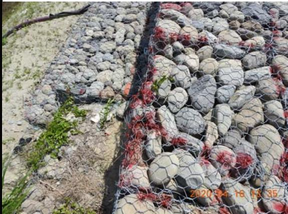
D 工區使用石籠護岸保有多孔隙及高透水性且有利植生復育。
