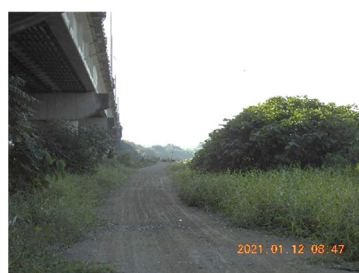
B 工區施工便道利用堤前既有便道及復原情形
