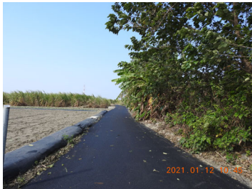
取土區(位安順堤防堤外臨河處)施工便道復原情形
