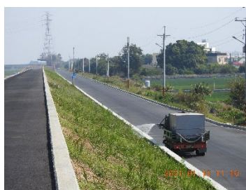
A 工區堤後鋪設稻草蓆及定期澆灌維管可促進植被回復
