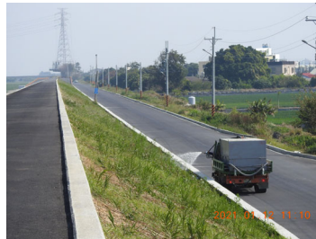
A 工區堤後鋪設稻草蓆及定期澆灌維管可促進植被回復
