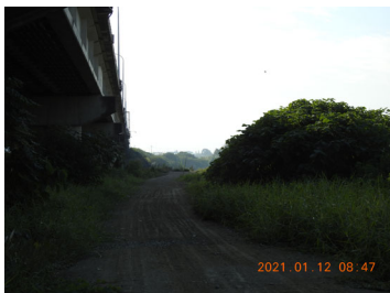
B 工區施工便道利用堤前既有便道及復原情形
