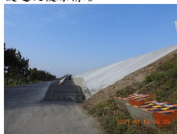
C 工區海寮堤防以最小利用為原則
