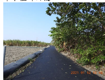
取土區(位安順堤防堤外臨河處)施工便道復原情形
